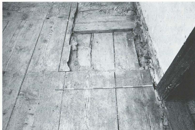
Abb. 572 Burg Zug. Raum RN 37. Blick auf den Bretterboden PN 882 (Bauphase XVII), darunter Bodenbretter PN 884 (Bauphase XVI). Im Zwischenraum fanden sich zahlreiche Funde (Mörtelstrich PN 1543 und Schuttestrich PN 1542).
