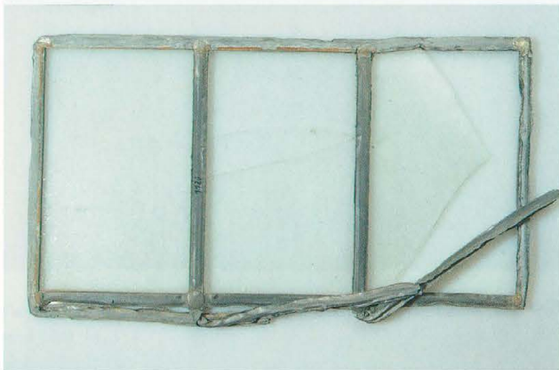
Abb. 491 Burg Zug. Muster der Bleiverglasung von 1890, farblos. Kat. 413. M. 1:5.
