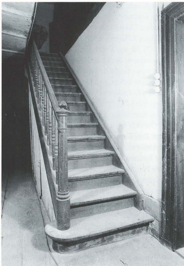
Abb. 281 Burg Zug 1975. Nordannex. Raum RN 24. Blick nach geographisch Südwesten. Der Treppenlauf ins dritte Obergeschoss.
