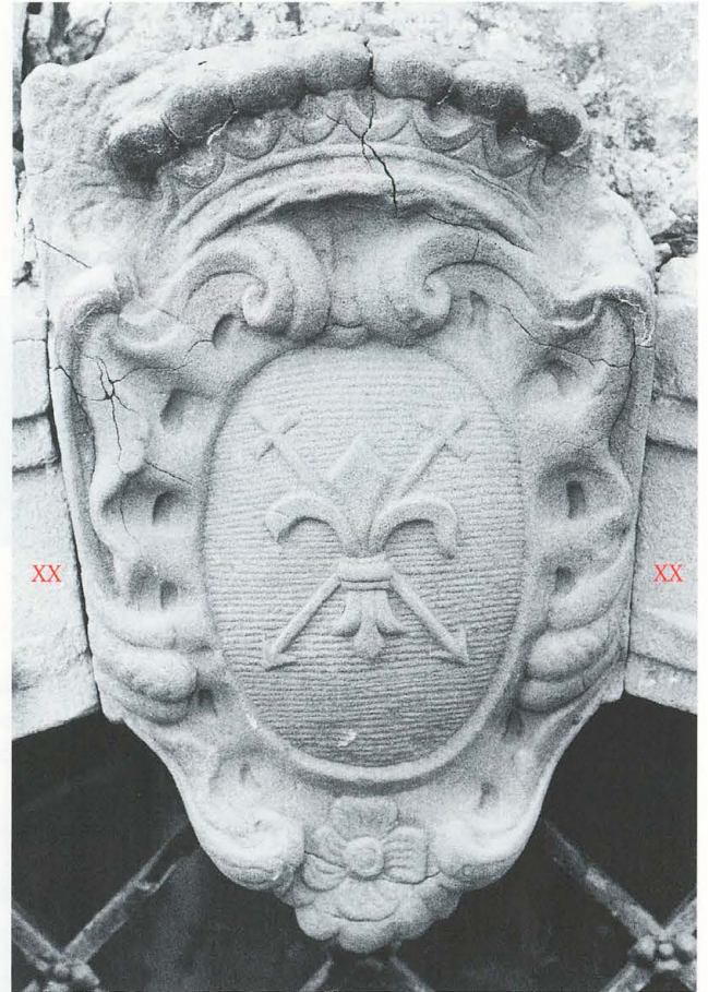
Abb. 263 Burg Zug 1979. Südfassade Turm. Blick nach geografisch Nordosten. Detail des Wappensteins mit dem Wappen der Familie Kolin.
