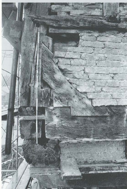
c: Nordannex. Westfassade. Blick nach Südosten.
