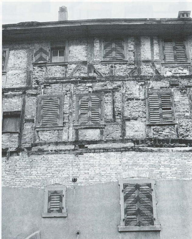
Abb. 294 Burg Zug 1978. Nordannex. Nordfassade. Blick nach geografisch Südwesten. Ersatz der Bodenbalken (VI) des zweiten Obergeschosses durch maschinengesägte Balken und Eisenträger (XXIII). Hölzer und Ausfachungen sind nicht auf Sicht gebaut. Unterhalb ist die spätere Unterfangung aus gelbem Lochbackstein (XXIV) sichtbar.
