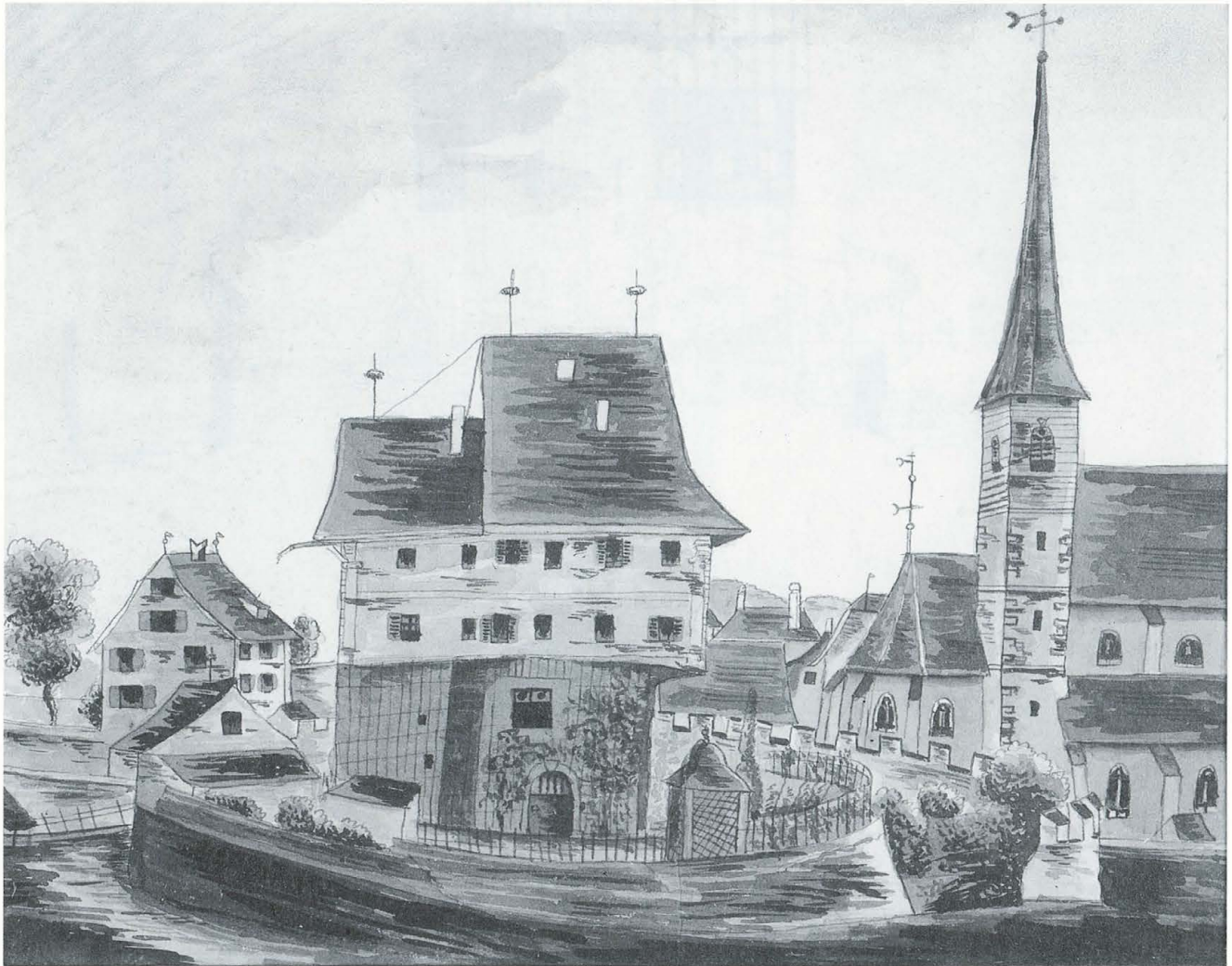
Abb. 291 Burg Zug. Blick nach geografisch Südwesten an die Nordfassade. Federaquarell Grisaille auf Papier, anonym, nach 1820. Die Nordfassade zeigt deutlich die Befensterung mit Einzelfenstern und Fensterladen. Die Dachform ist noch immer geteilt und entspricht den Phasen XVII und XVIII.
