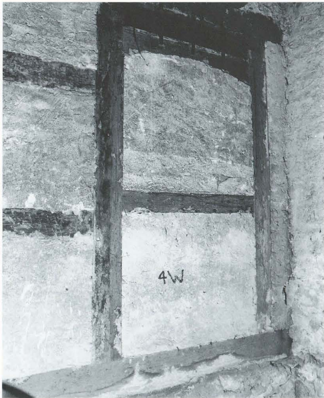
Abb. 250 Burg Zug 1975. Nordannex. Raum RN 4. Blick nach geografisch Norden auf die neu eingezogene Fachwerkwand mit vorbereiteter, aber nie verwendeter Tür.
