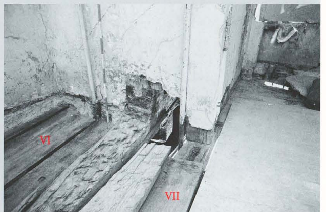
n: Nordostannex. Raum RN 28. Blick nach Norden.
