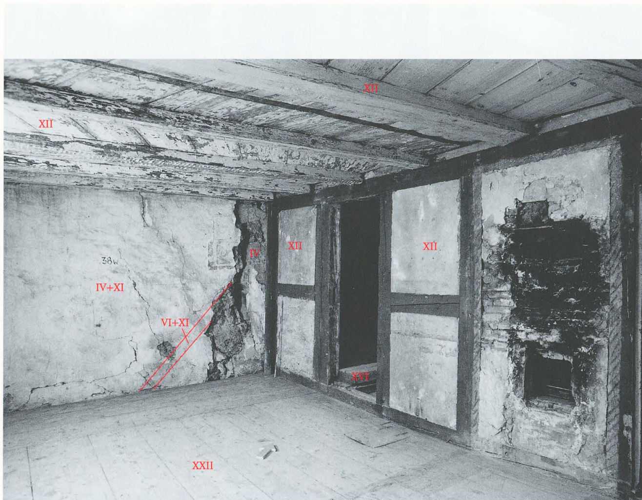
Abb. 77 Burg Zug 1977. Ostannex. Raum RN 44. Blick nach geografisch Norden zur ehemaligen Ostfassade des Turmes mit Dachschräge (VI), Eckquadermalerei (XI). Raumgefüge aus Phase XII.
