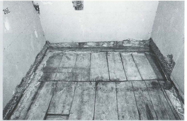
i: Nordannex. Raum RN 26. Blick nach Südwesten.
