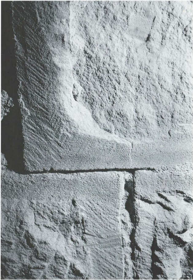
Abb. 46 Burg Zug 1980. Ostannex. Raum RN 18. Eckquader mit Randschlag. Ursprünglich vorstehende Bossen wurden später abgeschlagen.
