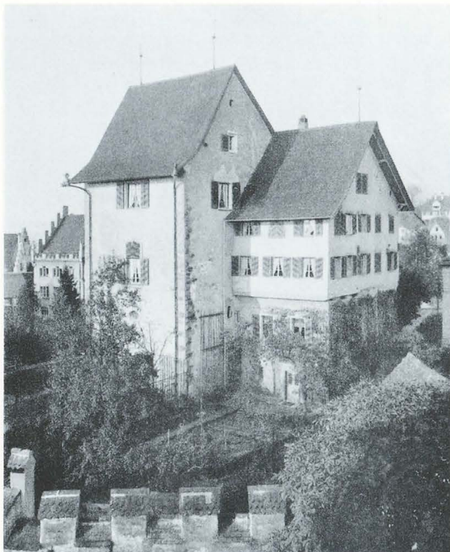
Abb. 332 Burg Zug vor 1935. Blick von geografisch Süden an die Süd- und Ostfassade. Zustand nach dem Umbau (XXV) mit vorkragendem Dach und bemalten Fensterläden.
