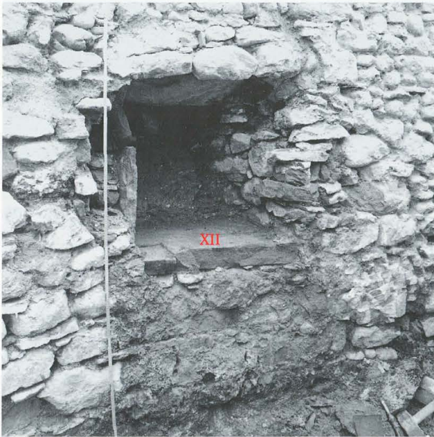
Abb. 118 Burg Zug 1979. Äussere Ringmauer. Blick nach geografisch Südwesten. Detail des Wassereinlasses von innen. Möglicherweise wurde das Wasser aussen mittels eines Kanals an die Ringmauer herangeführt.
