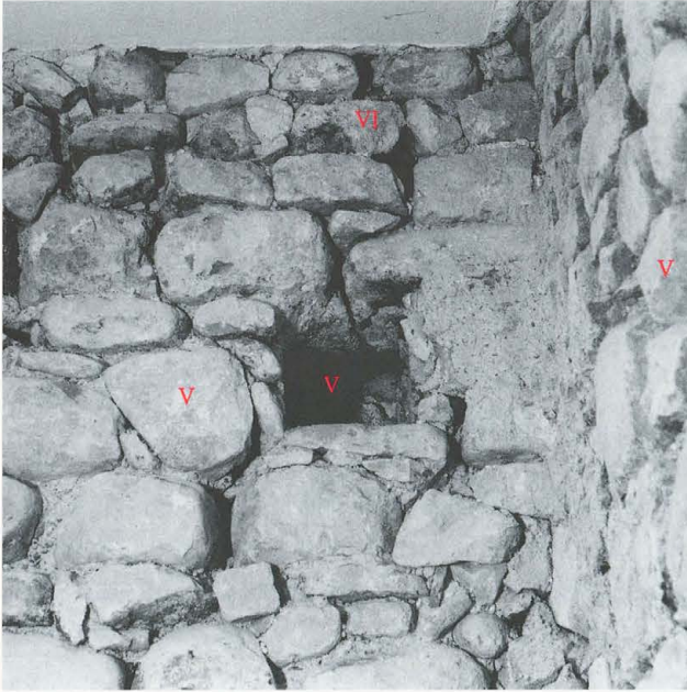
Abb. 59 Burg Zug 1980. Turm. Raum RN 33. Ostwand des Turmes. Originales Balkenloch im Aufstockungsmauerwerk.
