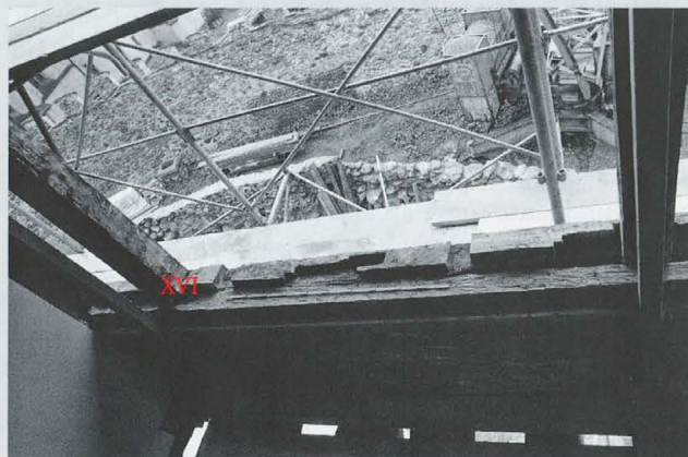
w: Nordannex. Raum RN 25. Blick nach Nordwesten.
