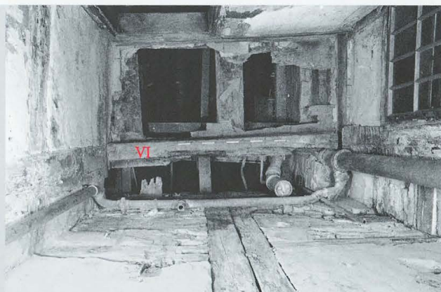
b: Nordannex. Raum RN 27. Blick von oben.
