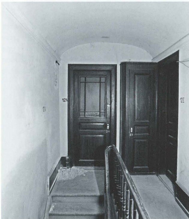
Abb. 313 Burg Zug 1975. Ostannex. Raum RN 12. Blick nach geografisch Nordosten mit Kellertreppe und neuen Zugängen zu WC und Küche.
