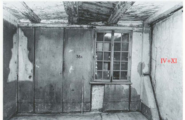
Abb. 289 Burg Zug 1977. Ostannex. Raum RN 44. Blick nach geografisch Südwesten. Das andere neu entstandene Zimmer mit Einzelfenster, durchgehender Vertäferung und Bretterboden. Rechts ist das Turmmauerwerk sichtbar.
