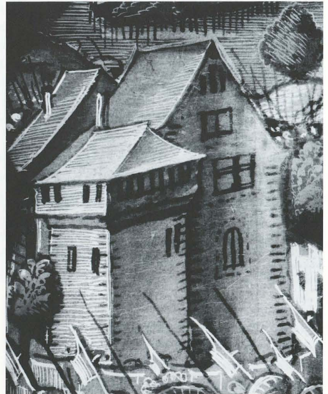
Abb. 157 Burg Zug. Detail aus der Bildscheibe des Hauptmannes Paul Stocker, datiert 1631. Glasgemälde von Melchior II. Müller ab Lauried. Es zeigt die Belagerung von Zug durch die Eidgenossen im Jahr 1352. Blick nach geografisch Süden an die Nord- und Westfassaden. Die Darstellung zeigt den Turm mit Giebelaufmauerung (Phase IX), den Nordannex mit eingeschossigem Holzaufbau und abgeändertem Dach (ab Phase XIV), den Ostannex (Phase XII) und die äussere Ringmauer mit Zinnen (Phase XI). Beachtenswert sind die Kamine (ab Phase XIII) und die Dachlösung zwischen Nord- und Ostannex (Phase XIV). Vergrösserung ca. 3,5fach.
