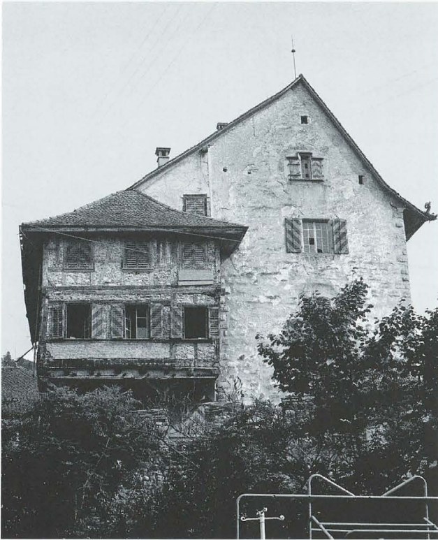
Abb. 94 Burg Zug 1977. Die Westfassade vor der Restaurierung.
