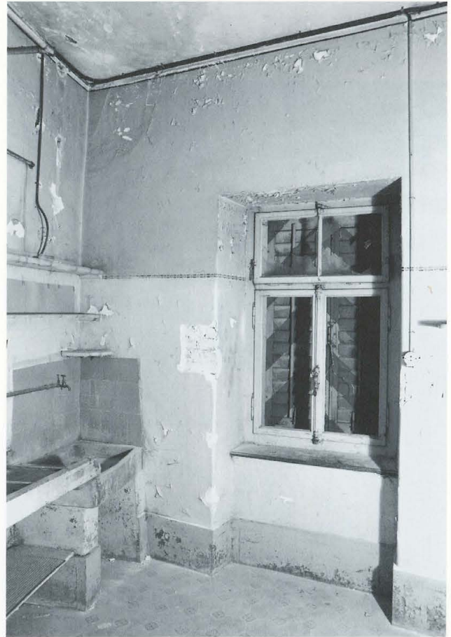
Abb. 317 Burg Zug 1975. Ostannex. Raum RN 16. Blick nach geographisch Nordosten. Küche mit steinernem Spühlrog.
