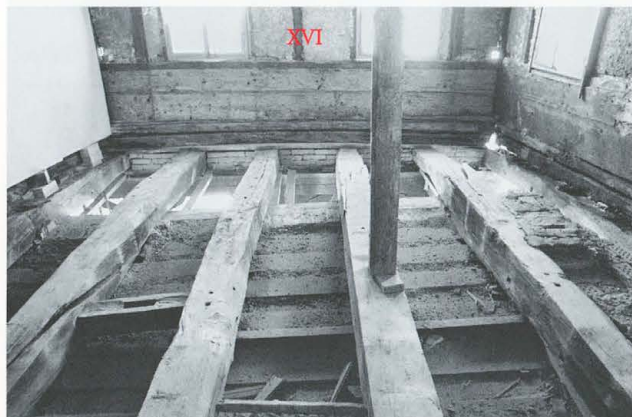
a: Nordannex. Raum RN 25. Blick nach Nordwesten.
