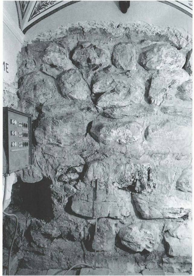
Abb. 47 Burg Zug 1979. Nordannex. Raum RN 11. Ansicht der ehemaligen Nordfassade des Turmes.
