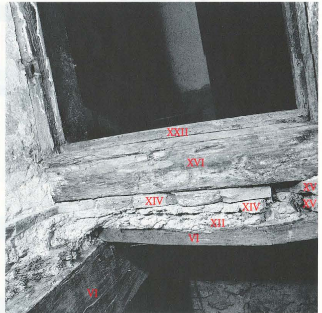
Abb. 153 Burg Zug 1978. Nordostannex. Raum RN 27. Blick nach geografisch Nordwesten. Unter der Bodenschwelle (XVI) befinden sich der Unterlagsmörtel mit Backsteinplatten (XIV), der Küchenmörtelboden (XII) und der Bretterboden mit Tragebalk (VI).
