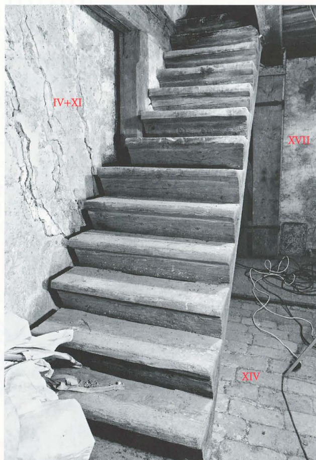
Abb. 140 Burg Zug 1975. Ostannex. Raum RN 49. Blick nach geografisch Nordosten. Blocktreppe ins Dachgeschoss (XII).
