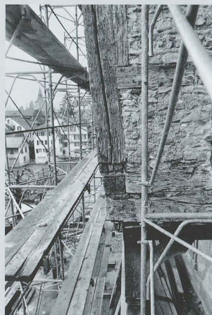
e: Nordannex. Südfassade. Blick nach Nordosten.
