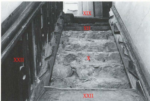
Abb. 100 Burg Zug 1978. Turm und Nordannex. Räume RN 20/22. Blick nach geografisch Nordosten. Neuer Turmdurchbruch mit Treppenlager zur Steintreppe und Bretterboden (XIX).
