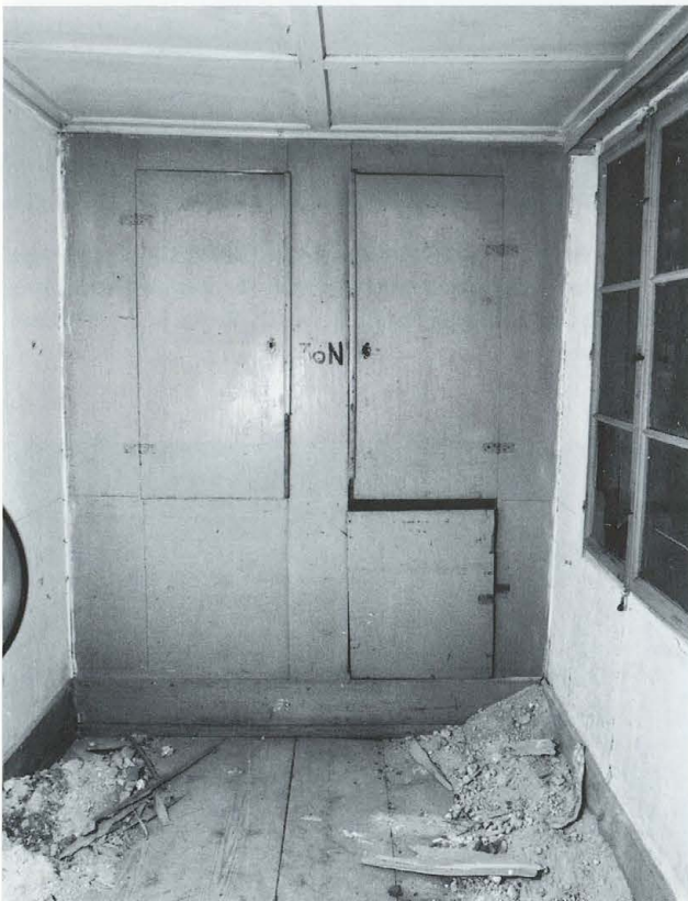
Abb. 284 Burg Zug 1975. Ostannex. Raum RN 30. Blick nach geografisch Nordosten. Der doppelte Wandschrank lässt vermuten, dass das neue Zimmer (RN 30) als Ankleideraum genutzt wurde.
