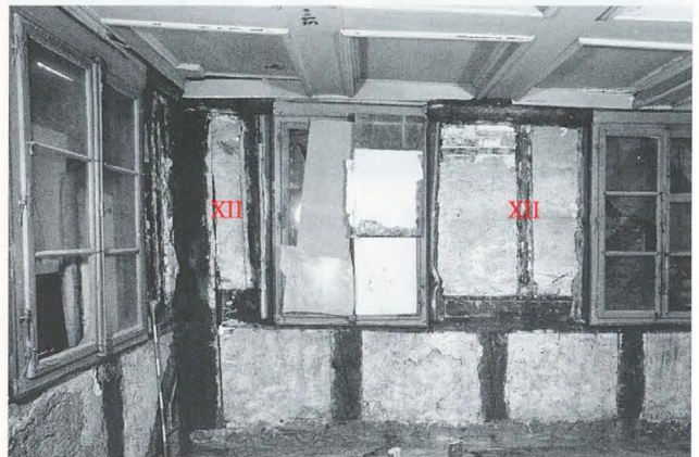
Abb. 130 Burg Zug 1978. Ostannex. Raum RN 31. Blick nach geografisch Südwesten. Reste der originalen Befensterung in der Süd- und Ostfassade sowie nachträglich eingebaute Einzelfenster (XXII). Oben Kasettendecke aus Phase XII.
