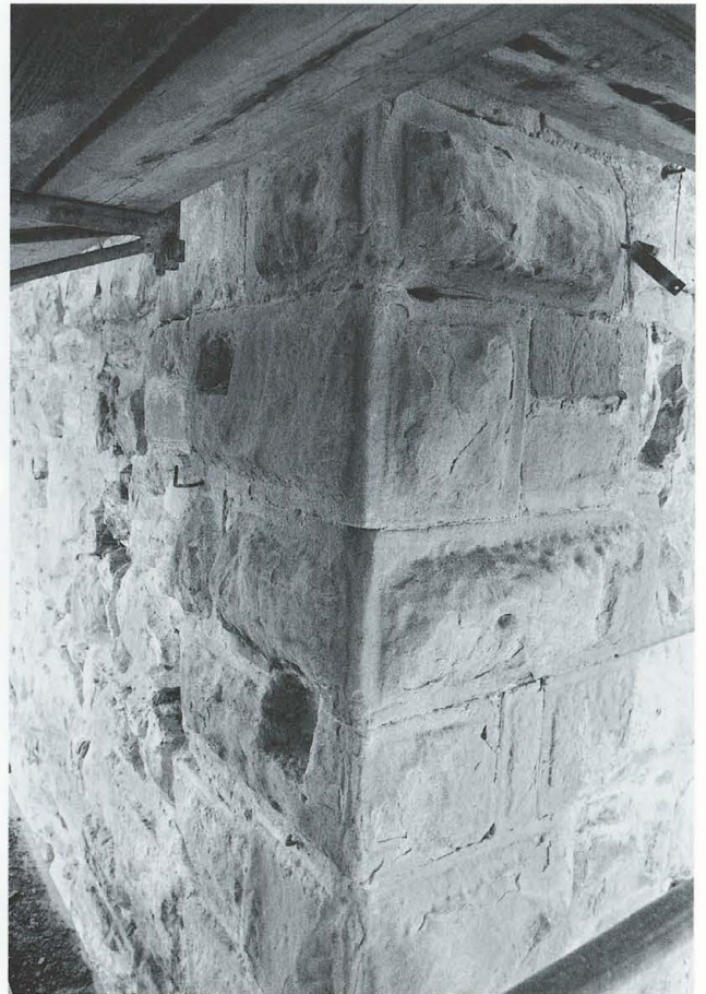
Abb. 45 Burg Zug 1980. Blick von geografisch Westen an die Südwestecke des Turmes. Bossierte Eckquader mit Randschlag.
