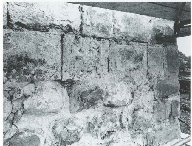
Abb. 50 Burg Zug 1979. Westfassade des Turmes. Übergang vom Megalith- zum Tuffsteinmauerwerk.
