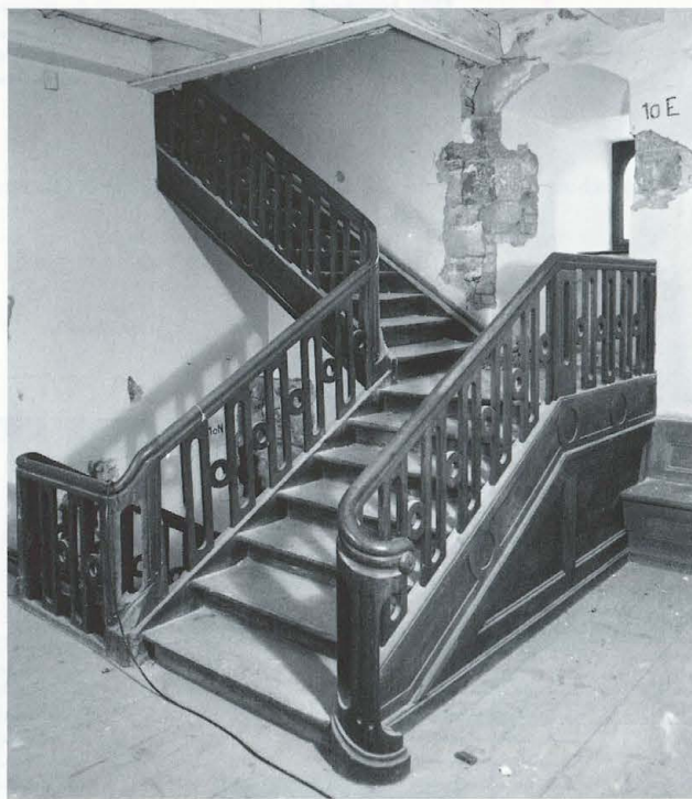
Abb. 274 Burg Zug 1975. Turm. Raum RN 10. Blick nach geografisch Osten. Die neue Treppenanlage aus Phase XXII.
