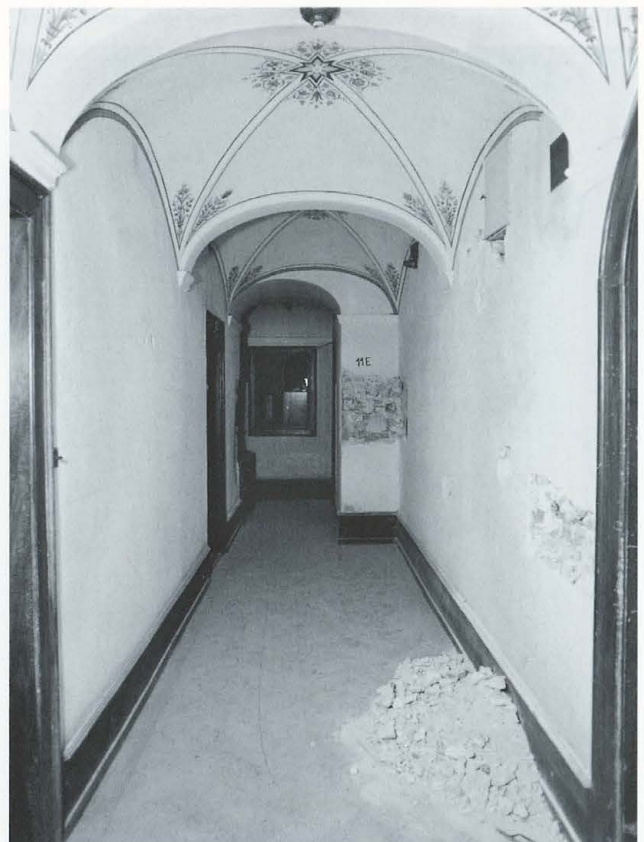
Abb. 335 Burg Zug 1975. Nordannex. Raum RN 11. Blick nach geografisch Südosten. Neu mit Gipsgewölbe versehener Korridorraum.
