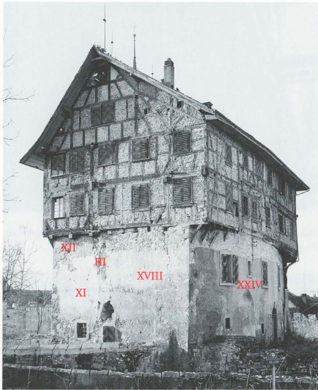
Abb. 128 Burg Zug 1978. Die Ost- und Nordfassade des Ost- bzw. Nordannexes.
