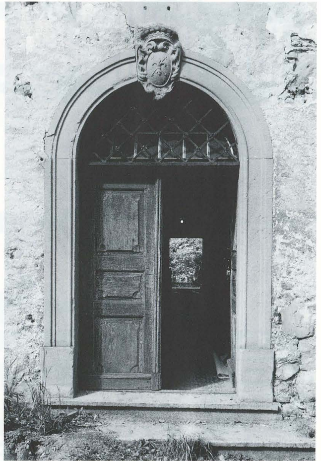
Abb. 244 Burg Zug 1970. Südfassade Turm. Ein neues in die Mittelachse gerücktes Portal (XX) ersetzt das alte aus Phase IX. Der Schlussstein mit dem Wappen der Familie Kolin wird in Phase XXI eingesetzt.
