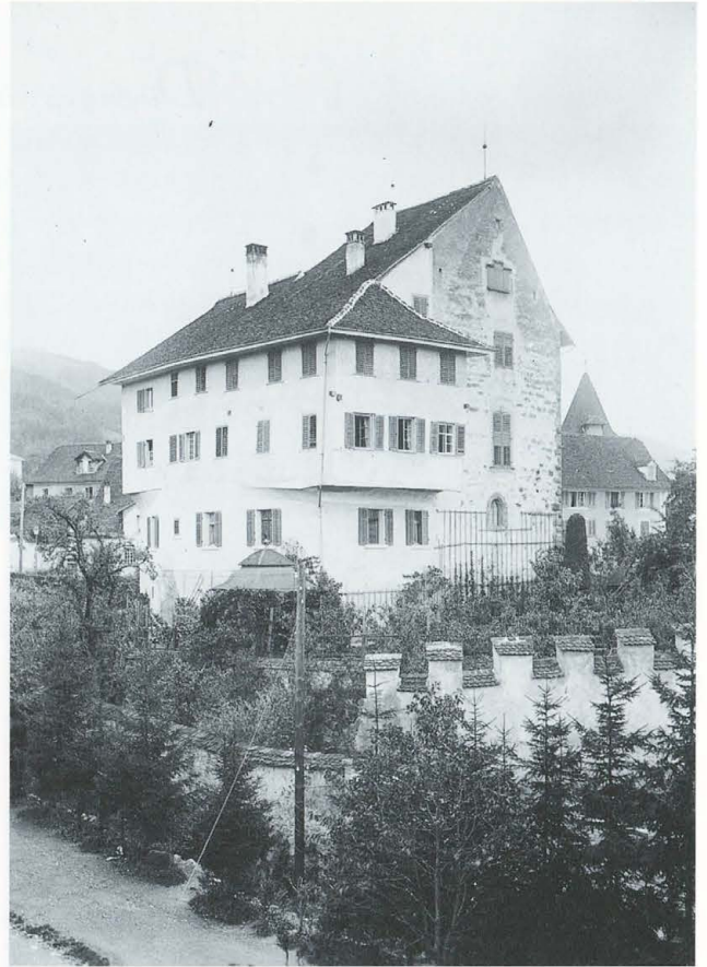
Abb. 307 Burg Zug etwa 1894. Blick nach geografisch Süden an die Nord- und Westfassade mit neuem Fassadenverputz (XXIV). Das erste Obergeschoss im Nordannex ist fertig gestellt (XXIV). Das ganze Gebäude wird von einem durchgehenden Dach abgeschlossen (XXIII).
