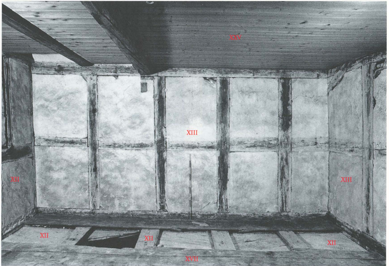
Abb. 150 Burg Zug 1978. Ostannex. Raum RN 48. Blick nach geografisch Südwesten. Nachträglich eingebautes Zimmer im Dach.
