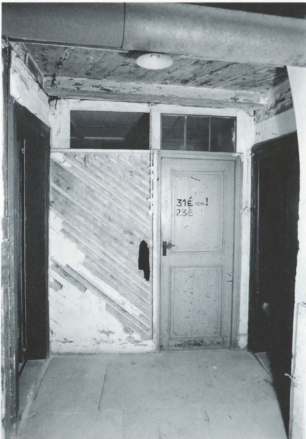
Abb. 241 Burg Zug 1975. Ostannex. Raum RN 23. Blick nach geografisch Südosten. Sandsteinplattenboden (XIX) und Trennwand zu Raum RN 30 am Ostende des Korridors (XXII).
