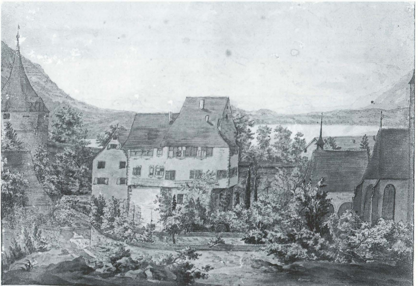
Abb. 259 Burg Zug. Aquarellierte Federzeichnung von J. M. Andlin, datiert 1794. Blick nach geografisch Südwesten an die Nord- und Westfassade. Die Darstellung zeigt den vollständig verputzten Nordannex mit den neuen Einzelfenstern (XXI) und den Kaminen. Ebenfalls sichtbar sind Fassadenmalereien, die Doppelfenster (XVII) und die Veranda im zweiten Obergeschoss des Ostannexes (XVIII). Im Vordergrund sind die neuen Ringmauern ohne Zinnen zu sehen (XXI).
