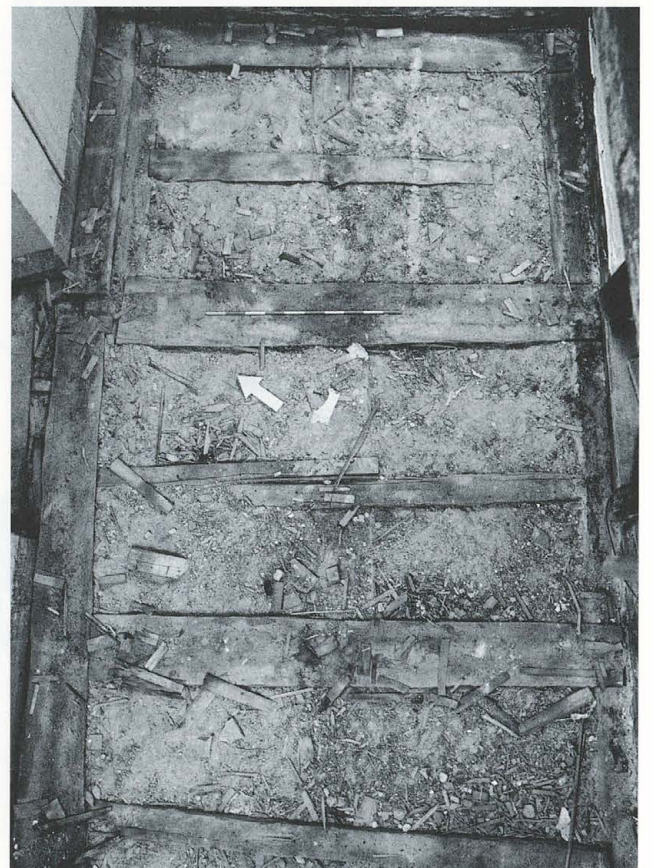
Abb. 298 Burg Zug 1977. Nordannex. Raum RN 38. Blick von oben. Unterkonstruktion und Schuttetrinch nach Entfernen des Bodens.
