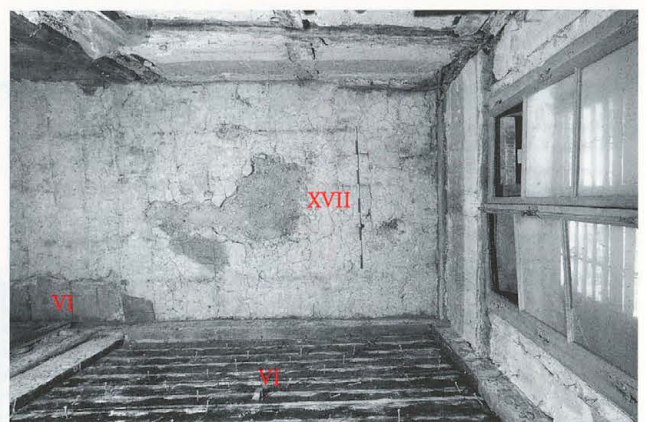
Abb. 183 Burg Zug 1977. Nordannex. Raum RN 21. Blick auf den Unterlagsmörtel des Tonplattenbodens (XVII). Unten im Bild ist die Bohlenständerwand der Phase VI sichtbar.
