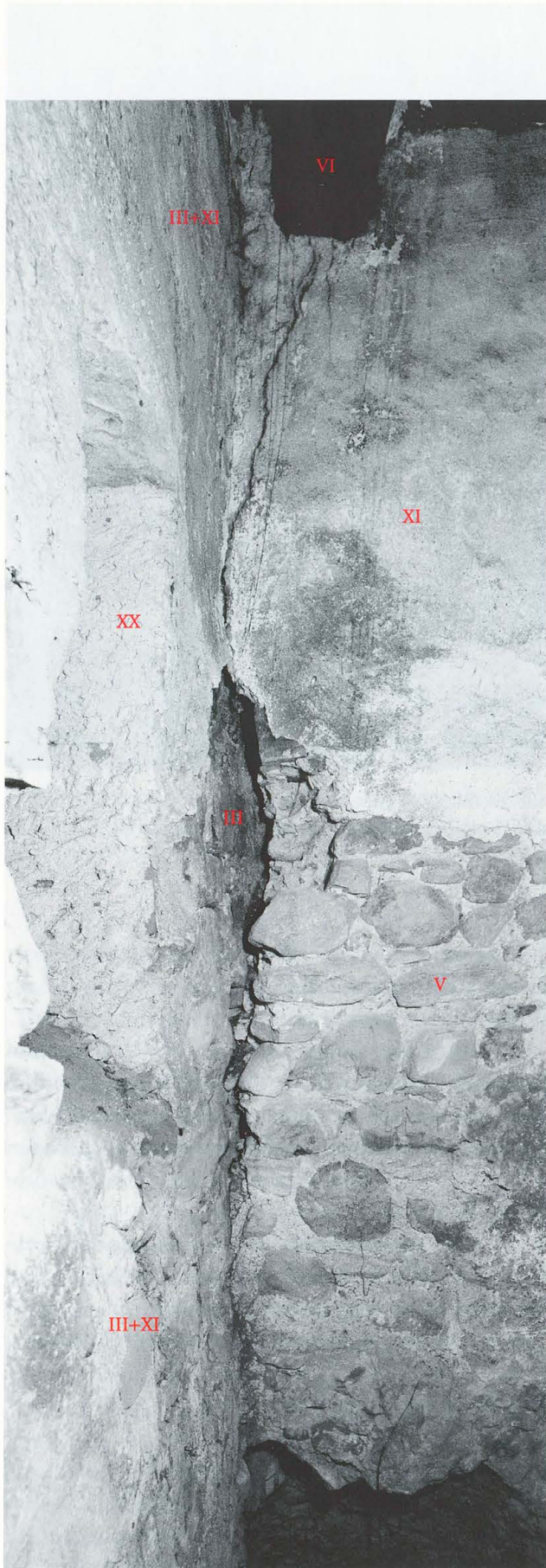
Abb. 61 Burg Zug 1975. Nordannex. Raum RN 4. Anschluss der östlichen Binnenmauer (PN 22, V) an die «Mantelmauer» (III).
