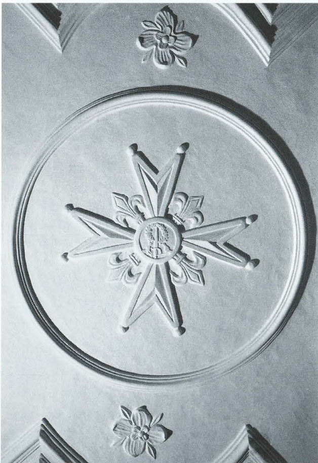
Abb. 238 Burg Zug 1982. Turm. Raum RN 33. Blick nach oben. Deckenrelief aus Gips nach der Restaurierung. Im Zentrum ein Medaillon mit dem Kreuz des Ludwigsordens, der 1719 Johann Franz Landtwing verliehen worden war.
