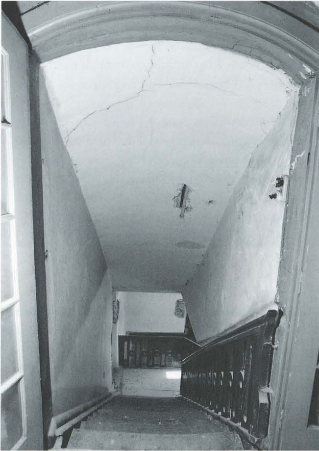
Abb. 306 Burg Zug 1975. Turm und Nordannex. Raum RN 10/22. Blick nach geografisch Südwesten. Neu mit Holz überwölbter Treppendurchgang zu Raum RN 10.
