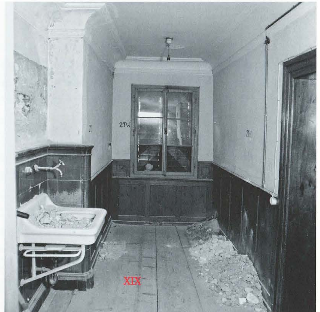
Abb. 239 Burg Zug 1975. Nordannex. Raum RN 21. Blick nach geografisch Nordwesten. Bretterboden (XIX) und Ausstattungen (XXV).
