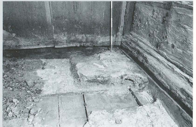
l: Nordannex. Raum RN 25. Blick nach Südwesten.
