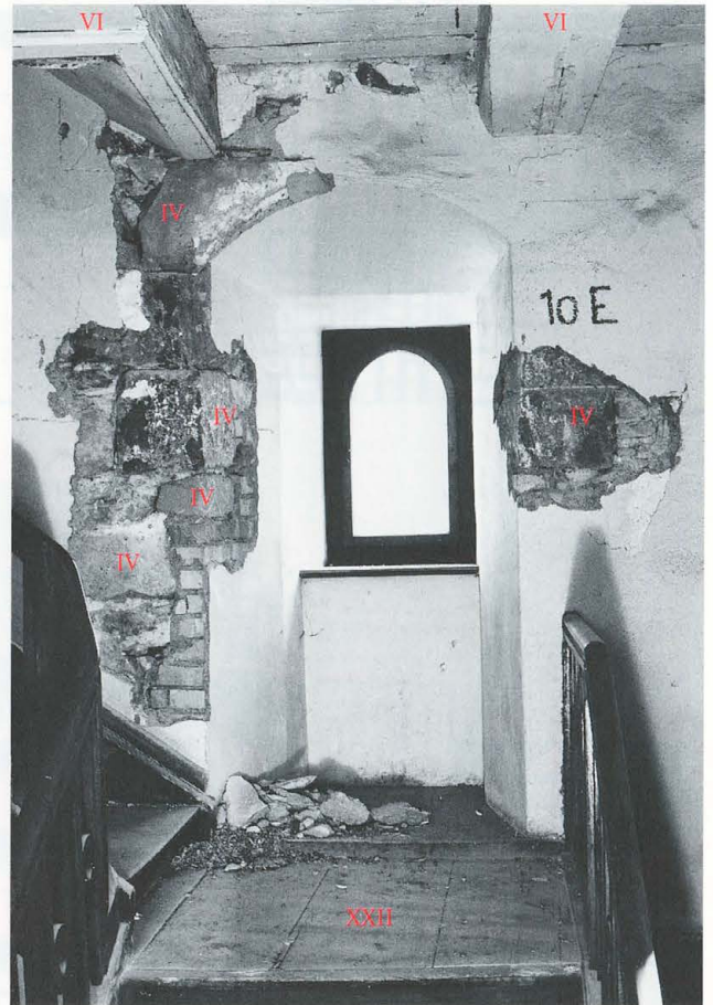
Abb. 324 Burg Zug 1975. Turm. Raum RN 10. Blick nach geografisch Südosten. Der umgebaute Lichtschlitz in der östlichen Turmmauer.
