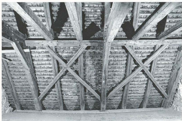
Abb. 96 Burg Zug 1975. Turm. Raum RN 50. Blick nach geografisch Südwesten. Liegender Dachstuhl mit so genannten Andreaskreuzen als Verstrebung.
