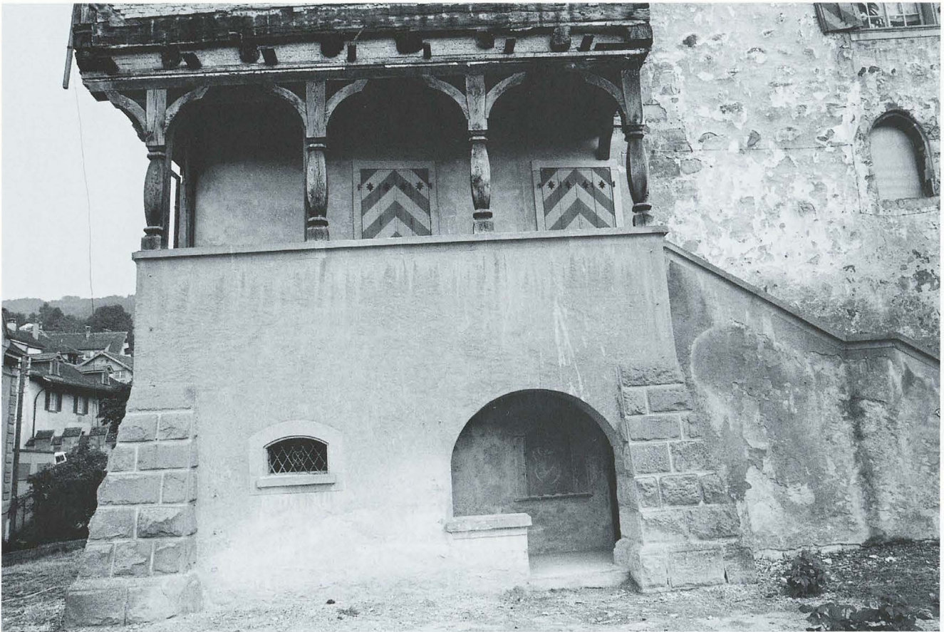
Abb. 334 Burg Zug 1978. Nordannex und Turm. Westfassade. Blick nach geografisch Südosten. Neubau der Veranda mit massivem Unterbau und Freitreppe. Am rechten Bildrand ehemaliger Hocheingang (V).
