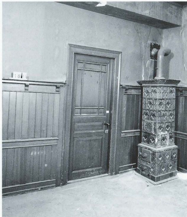
Abb. 315 Burg Zug 1975. Ostannex. Raum RN 18. Blick nach geografisch Osten. Neu eingebautes Täfer, Fischgratboden und dazugehöriger so genannter Tragofen.
