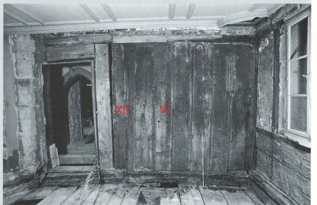
p: Nordannex. Raum RN 25. Blick nach Südwesten.
