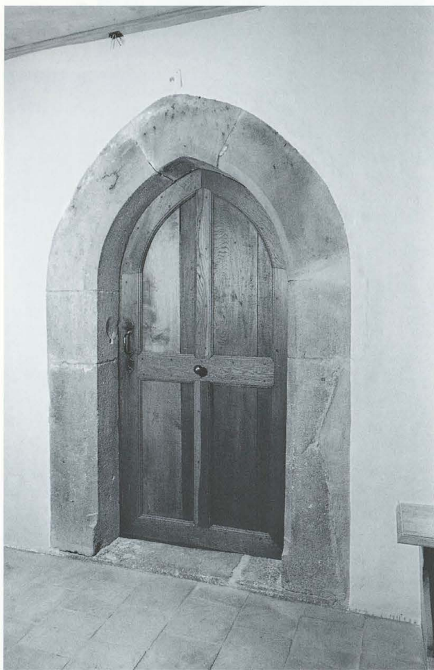
Abb. 144 Burg Zug 1982. Nordannex. Raum RN 21. Blick nach geografisch Südwesten. Spitzbogenportal zum Turm (XIII).
