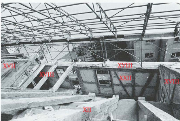
Abb. 228 Burg Zug 1979. Ostannex. Räume RN 41. Blick von oben nach geografisch Nordosten. Dieselbe Situation wie Abb. 227. Im Vordergrund Dachsparren des Ostannexes (XII), links Aufstockung des Nordannexes (XVII).
