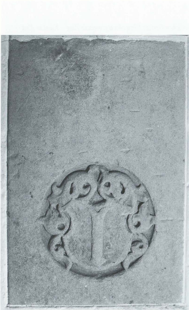
Abb. 325 Burg Zug 1975. Turm. Raum RN 10. Blick nach geografisch Südwesten. In der Fensterbrüstung als Spolie vermaueretes Grabsteinfragment mit Wappen der Familie Letter.
