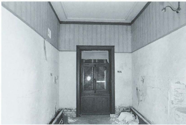
Abb. 309 Burg Zug 1975. Nordannex. Raum RN 14. Blick nach geographisch Nordosten in das neu entstandene Zimmer.
