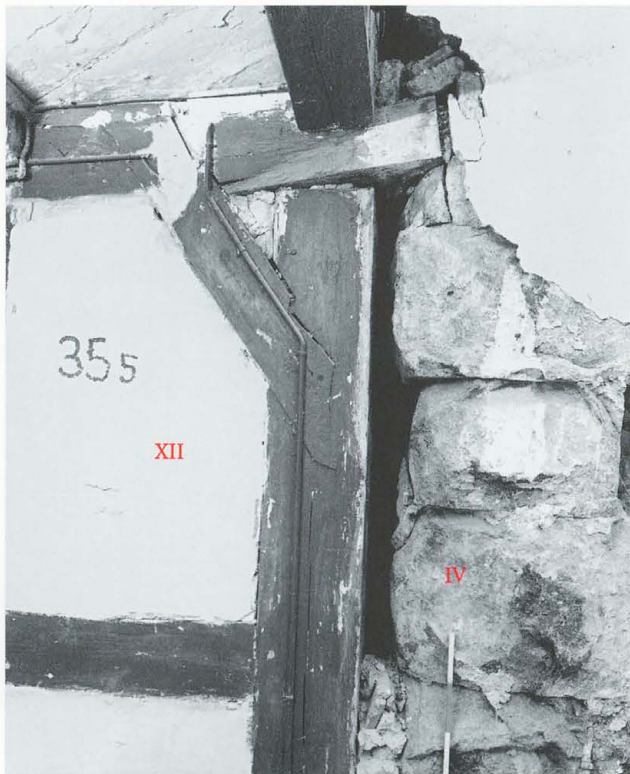
Abb. 135 Burg Zug 1977. Ostannex. Räume RN 34/35. Blick nach geografisch Südwesten. Detail der Nordostecke des Turmes (IV) und Anbau des Ostannexes mit eingelassenem Wandrähmbalken (XII).
