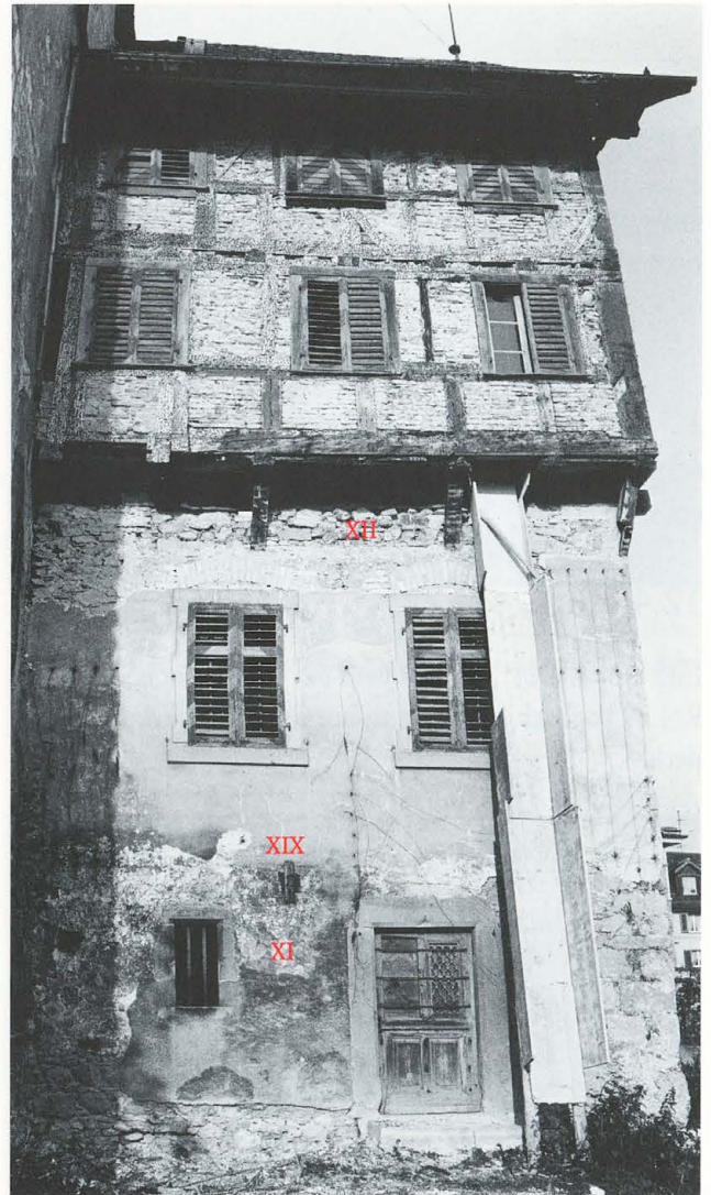
Abb. 127 Burg Zug 1977. Die Südfassade des Ostannexes.
