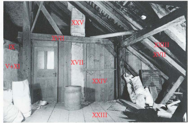
Abb. 300 Burg Zug 1975. Nordannex. Raum RN 45. Blick nach geografisch Nordwesten. Neu verlegte Bodenbretter im Dachraum. Das Zimmer wurde in Phase XXIV eingebaut.
