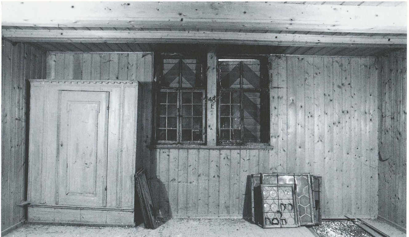
Abb. 340 Burg Zug 1975. Ostannex. Raum RN 48. Blick nach geografisch Südosten. Vollständige Vertäferung des Dachraumes mit so genanntem Krallentäfer.
