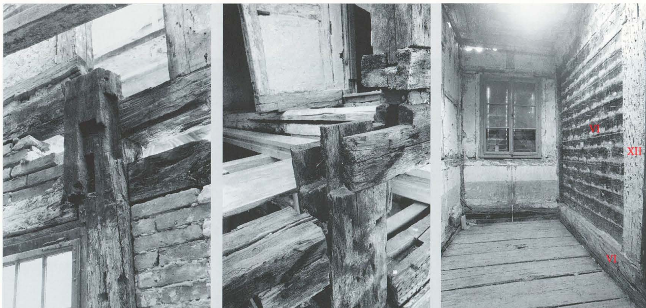
q: Nordannex. Raum RN 27/29. Blick nach Nordosten.
