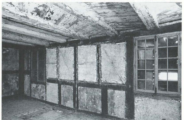
Abb. 131 Burg Zug 1977. Ostannex. Räume RN 43/44. Blick nach geografisch Süden. Zugebaute originale Befensterung und nachträglich eingebaute Einzelfenster (XXII).
