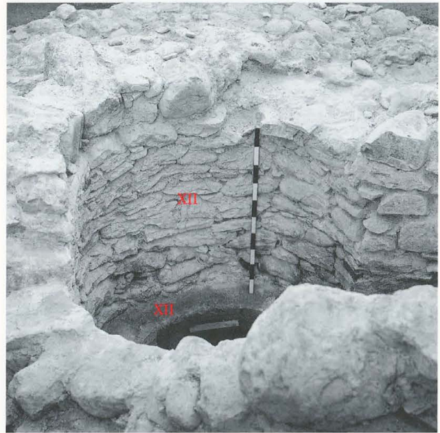
Abb. 119 Burg Zug 1967. Sodbrunnen (Feld O). Blick nach geografisch Südosten. Aufgemauerter Brunnenkranz mit Zugang zum Graben (rechts) und Fundament eines aufgebauten Brunnenhauses (XII).
