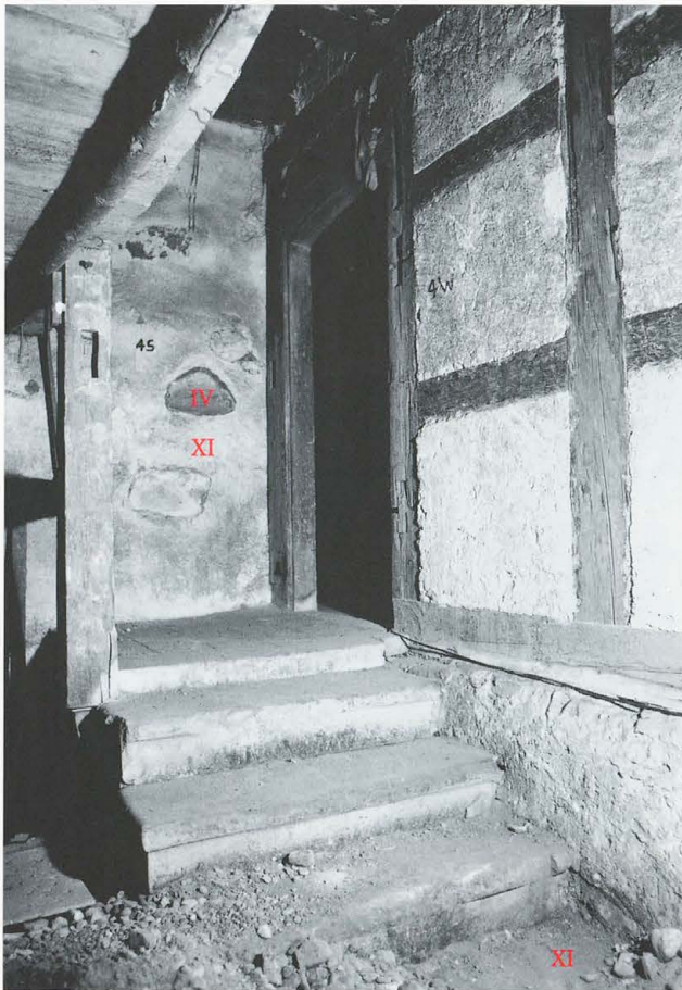
Abb. 253 Burg Zug 1975. Nordannex. Raum RN 4. Blick nach geographisch Südwesten. Neue Fachwerkwand und Treppenstufen (XX) zum alten Kellerboden (XI).
