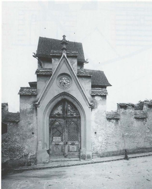
Abb. 292 Burg Zug 1970. Äussere Ringmauer. Blick nach geografisch Nordosten. Das kurz danach abgebrochene neugotische Tor, das in die äussere Ringmauer (XI) eingebaut wurde.
