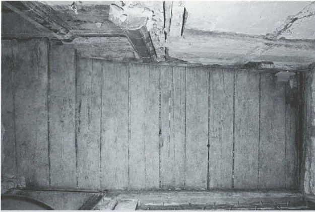
b: Nordannex. Raum RN 21. Blick von oben.
