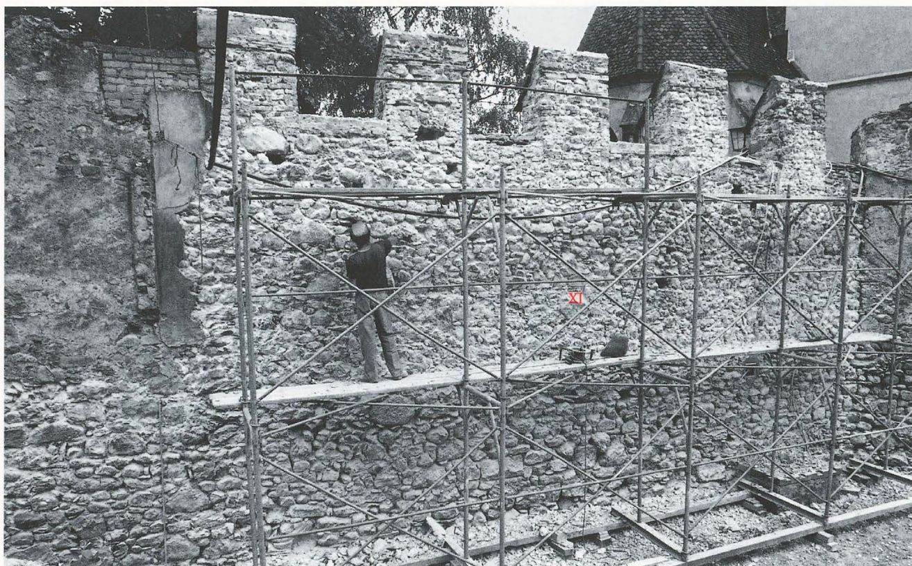
Abb. 103 Burg Zug 1979. Innenseite der äusseren Ringmauer während der Renovierung. Blick nach geografisch Südwesten.
