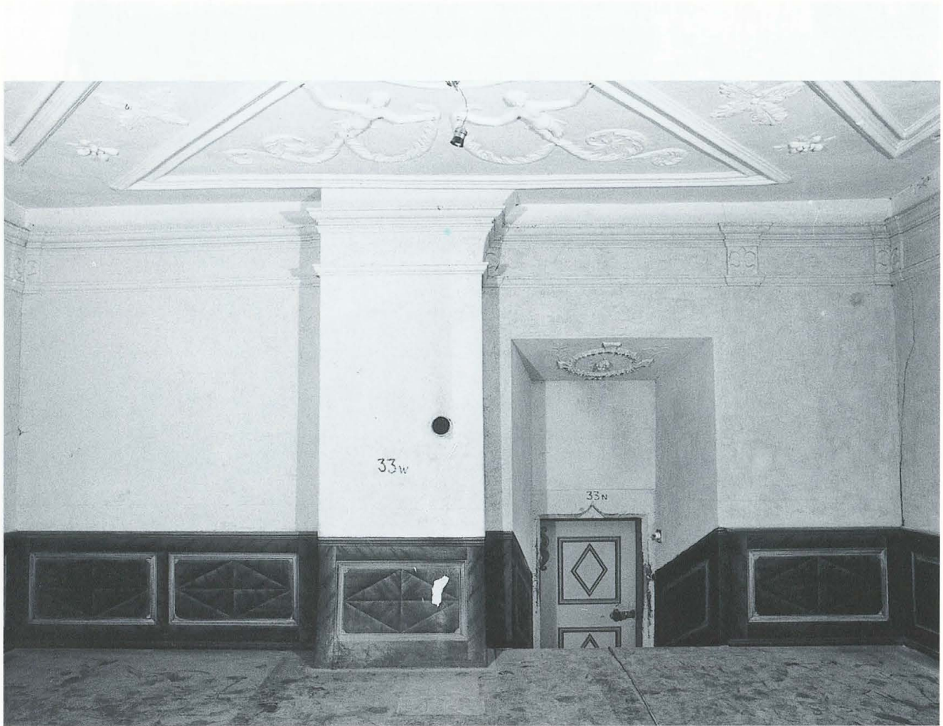
Abb. 329 Burg Zug 1975. Turm. Raum RN 33. Blick nach geografisch Nordosten (vgl. Abb. 60). Neues, bemaltes Sockeltäfer und Bretterboden (Hartholzriemen mit Weichholzfüllung).
