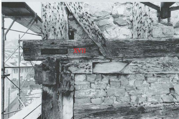
t: Nordannex. Westfassade. Blick nach Nordosten.
