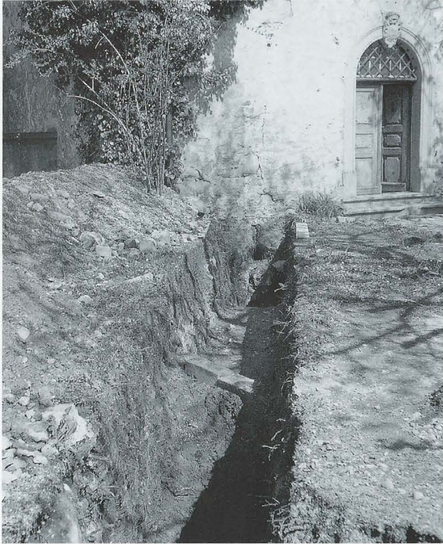
Abb. 1 Burg Zug 1967. Schnitt S 5. Blick zur Südfassade des Turmes. Sondierung John Witmer.
