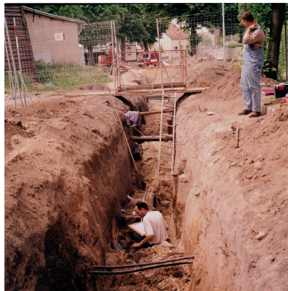
Abb. 8 Satzkorn – Baubegleitende Untersuchung in Potsdam-Satzkorn: Blick in den rund 2 m breiten Graben zur Aufnahme der Schmutzwasser-Leitung mit den Mitarbeitern Alessandro Soto-Roco (unten) und Sven Friedrich. Blick nach Nordnordwest, am Bildrand ganz links zur Orientierung der hölzerne Feuerwehr-Schlauchturm (Foto April 1999).
