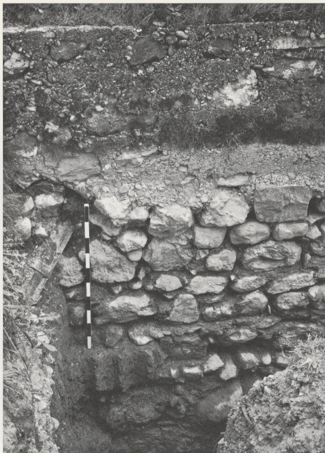
Abb. 10 Näfels, Letzi beim Schlachtdenkmal (feindseitig), 1970; man beachte links unten die Mörtelbrauen von vorgestellten Stützpfehlen.
