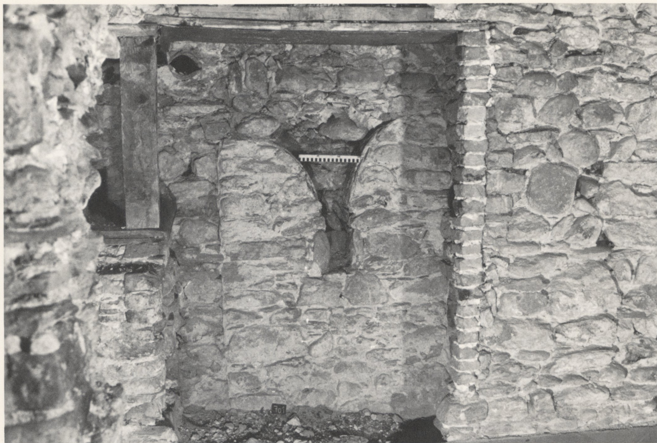
Abb. 23▲ Ältere Schwalbenschwanzzinne (13. Jahrhundert) in Haus 4
