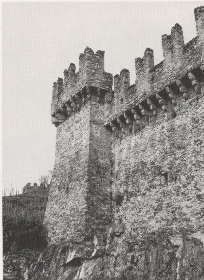
Abb. 47 Verbindungsmauer von der Stadt zum Castel Grande, Eckturm mit Zinnenkranz aus dem 15. Jahrhundert
