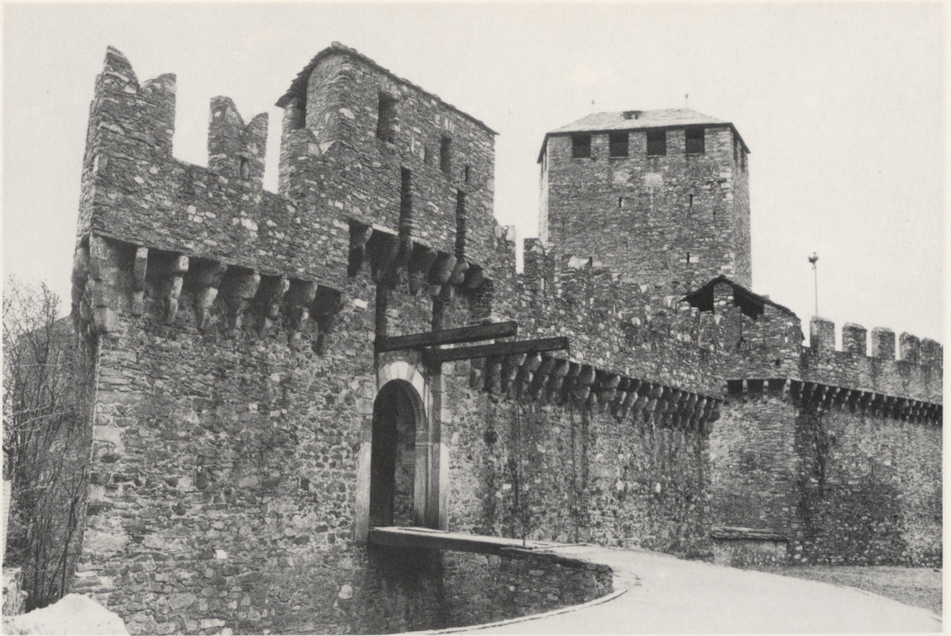
Abb. 44 Castello di Montebello, äussere Toranlage
