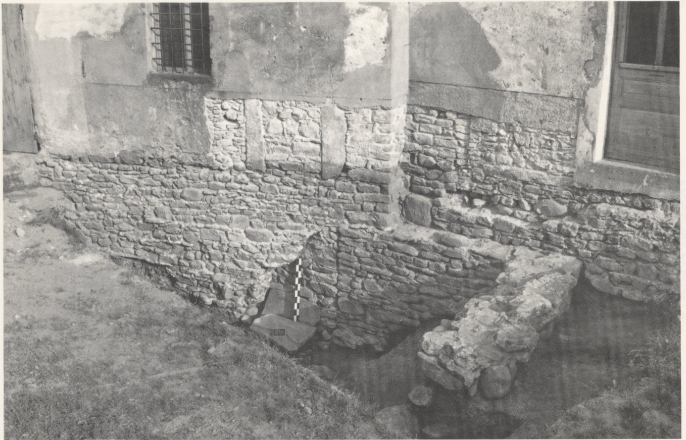
Abb. 13 Mauerwerk aus verschiedenen Epochen nördlich des Südtraktes: spätrömische Ringmauer M 3, Turmfundament M 1 aus der Zeit um 900, darüber hoch- und spätmittelalterliche Hausfundamente in Q 14
