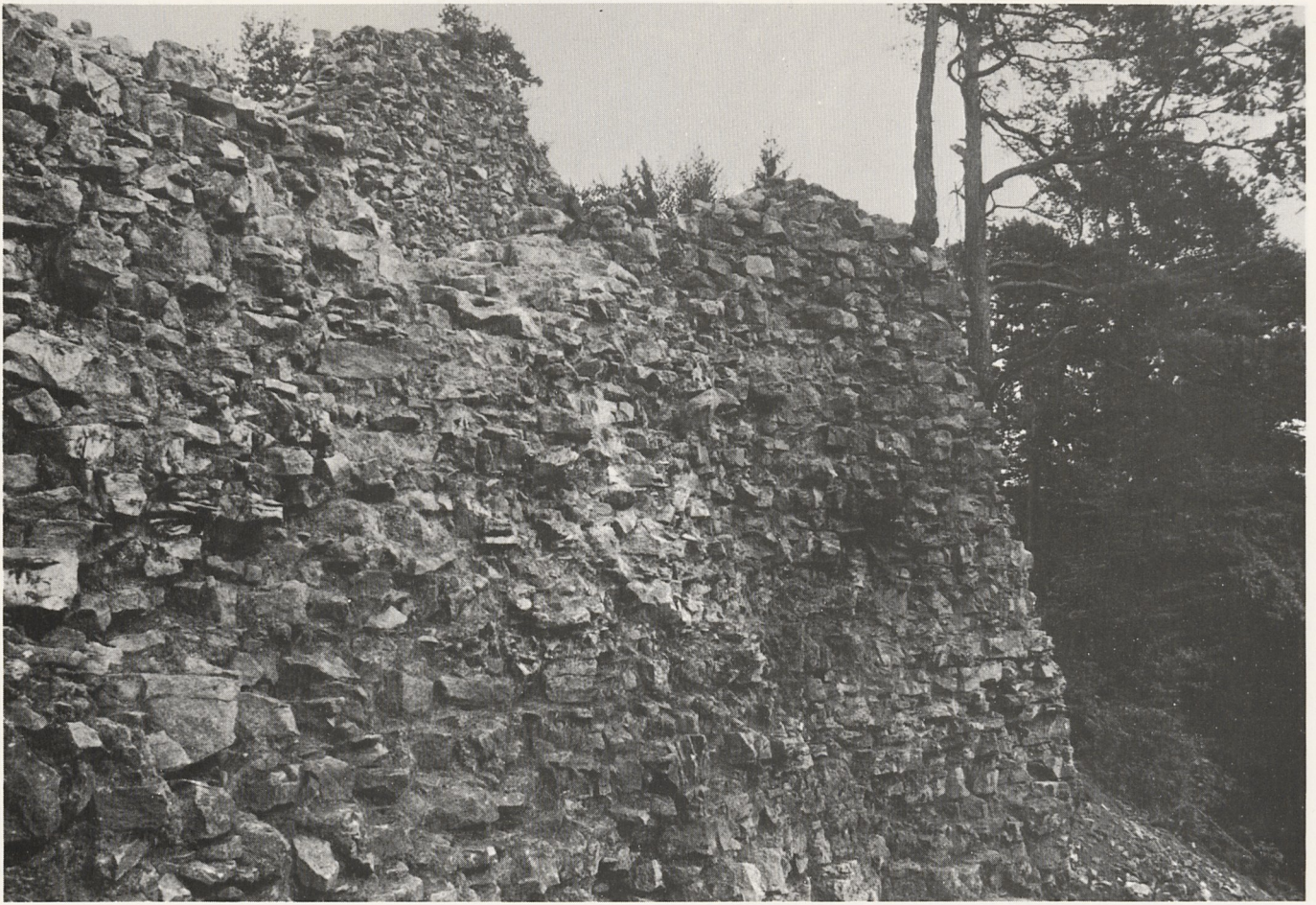
Abb.68: An Mauer 5 (hier von Nordwesten) ist die Außenhaut vollkommen abgewittert.
