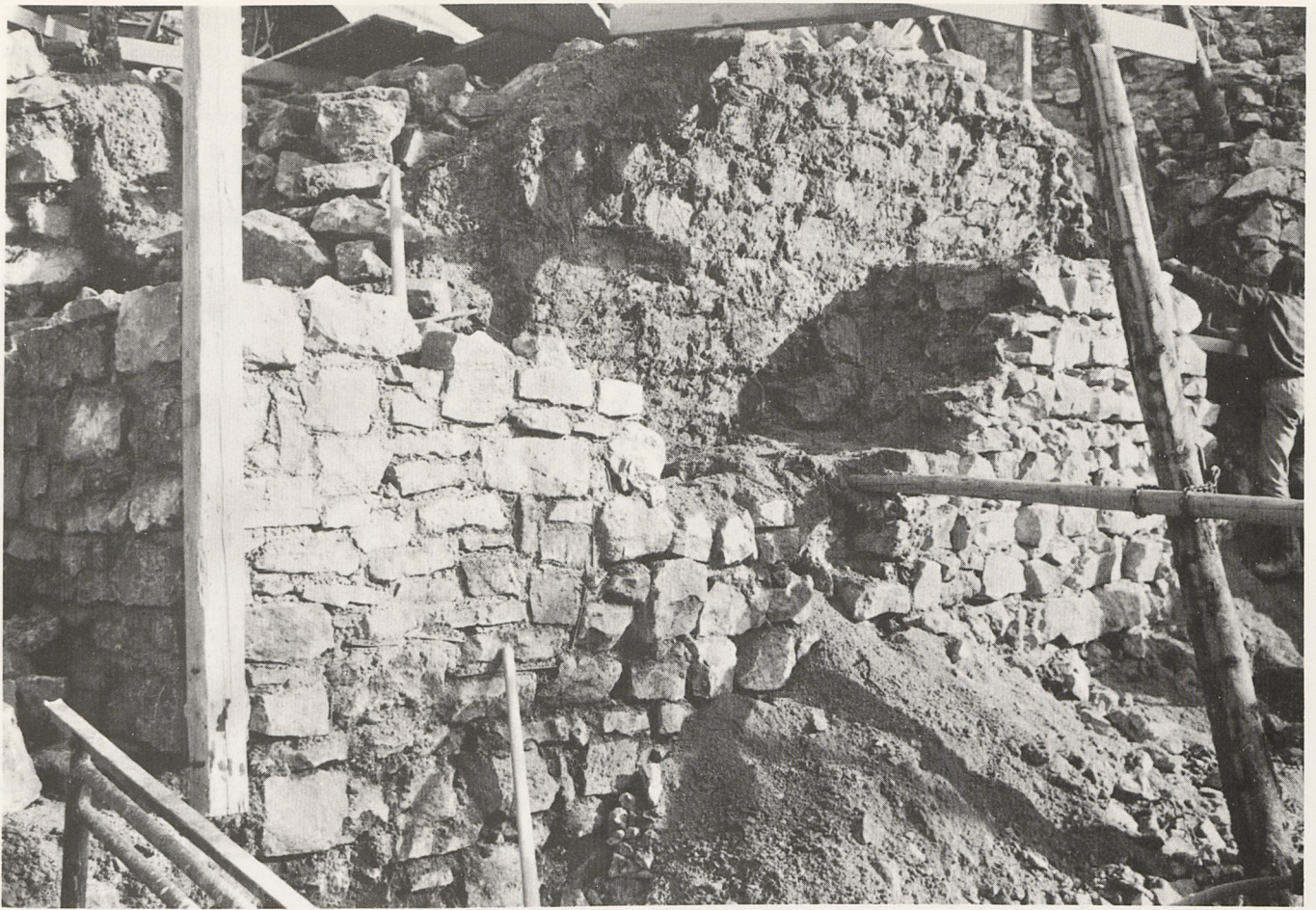
Abb.70: Die Zisterne während der Konservierung. Nach dem Abbau schadhafter Partien von Mauer 10 zeigt sich das Negativ der Mauer im Dichtungslehm (oben Mitte). Von Nordwesten.
