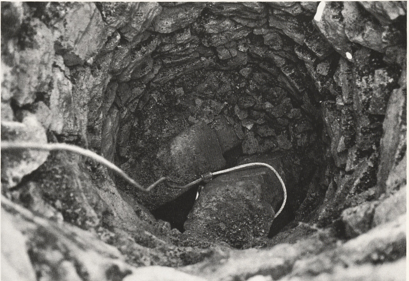
Abb.31: Fenstergewände im Schöpf-schacht der Zisterne.
