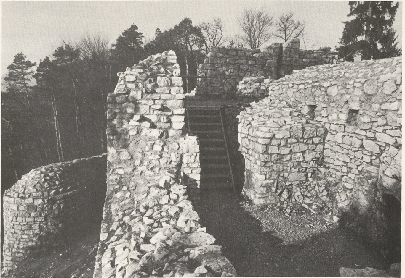
Abb. 74: Die konservierte Anlage vom Keller aus gegen Norden gesehen. Die moderne Hilfstreppe führt zum Ausgang des Wohnturmes in Mauer 2. Links unten der Torweg mit der endverstärkten flankierenden Mauer 5.
