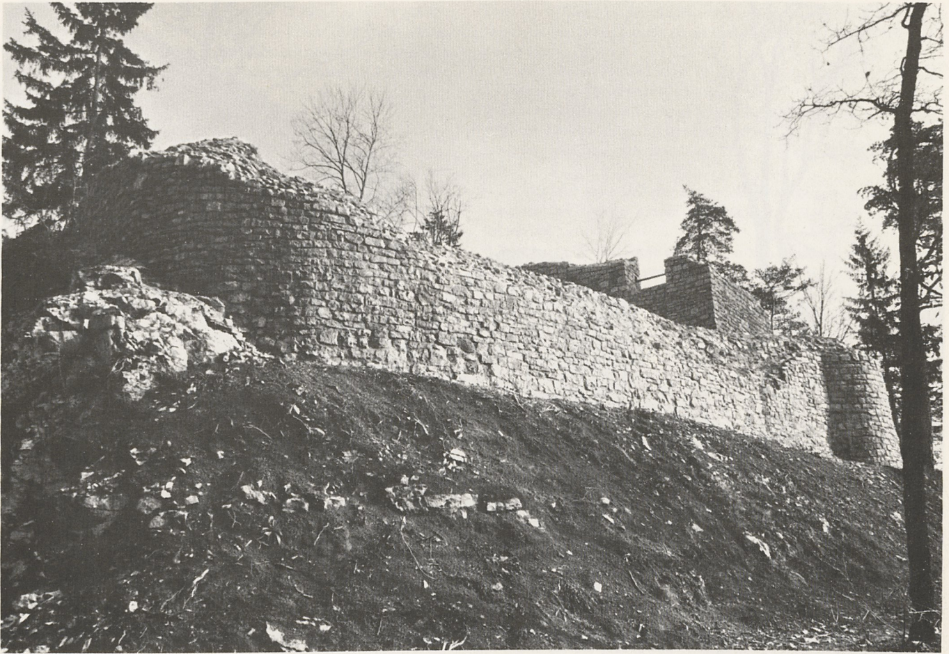
Abb. 64: Die wieder aus den Trümmern gehobene konservierte Anlage von Nordwesten.
