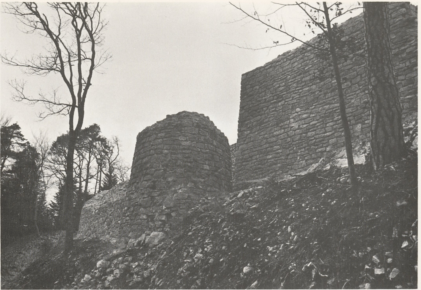
Abb.65: Blick von Südwesten gegen das Tor. Rechts Mauer 1, links der konservierte «Rundturm».
