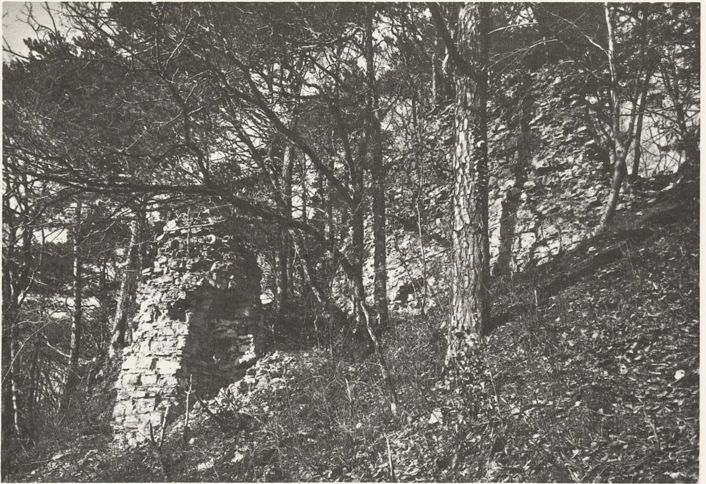
Abb. 5: Zustand der Ruine um 1932. Blick von Südwesten her an die runde Endverstärkung von Mauer 5 (links).
