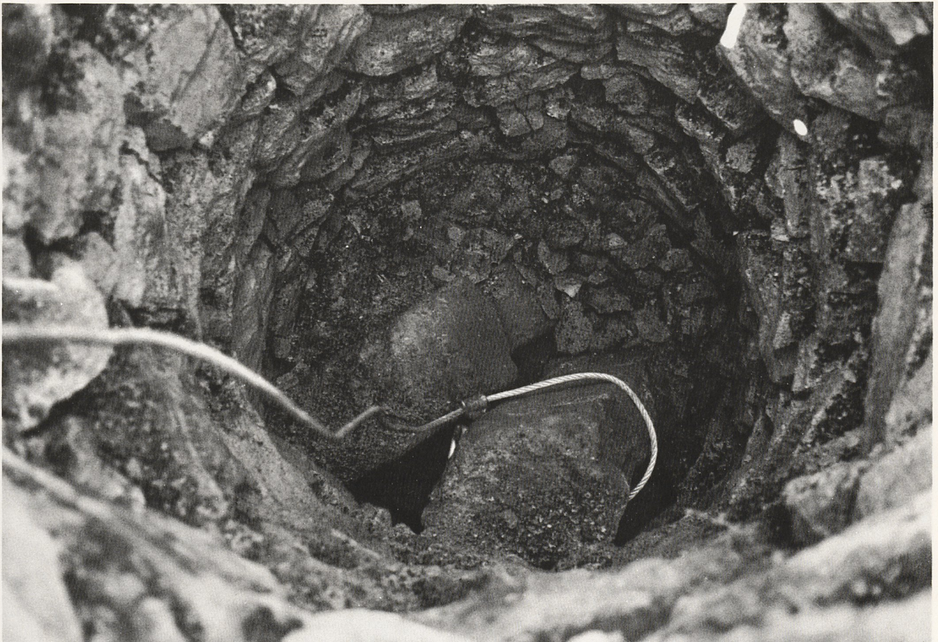
Abb.31: Fenstergewände im Schöpf-schacht der Zisterne.
