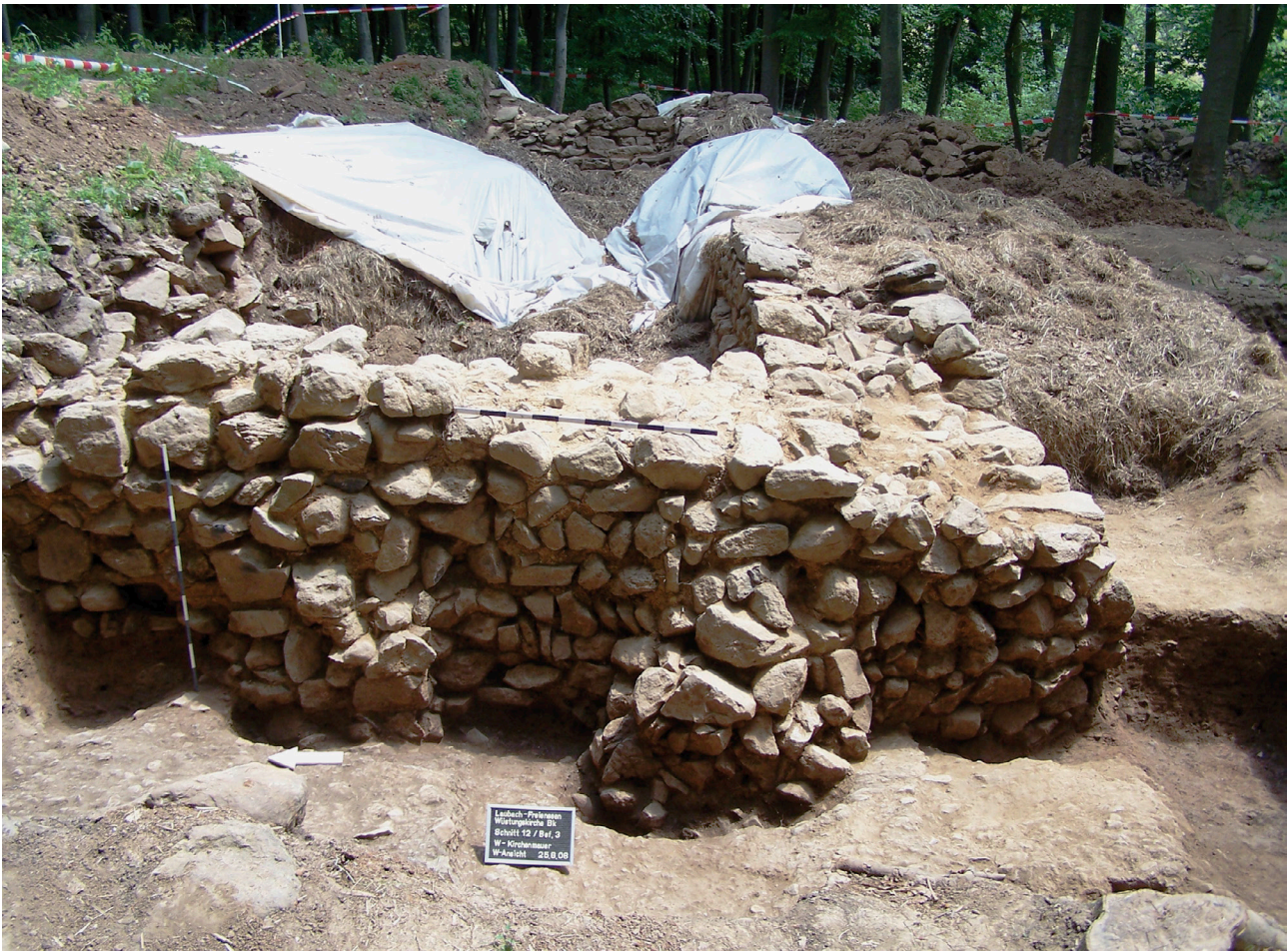
Abb. 10. Die pfeilerartigen Befunde 242 (rechts) und 243 an der Außenseite der Kirchenwestmauer (Foto: LfdH).
