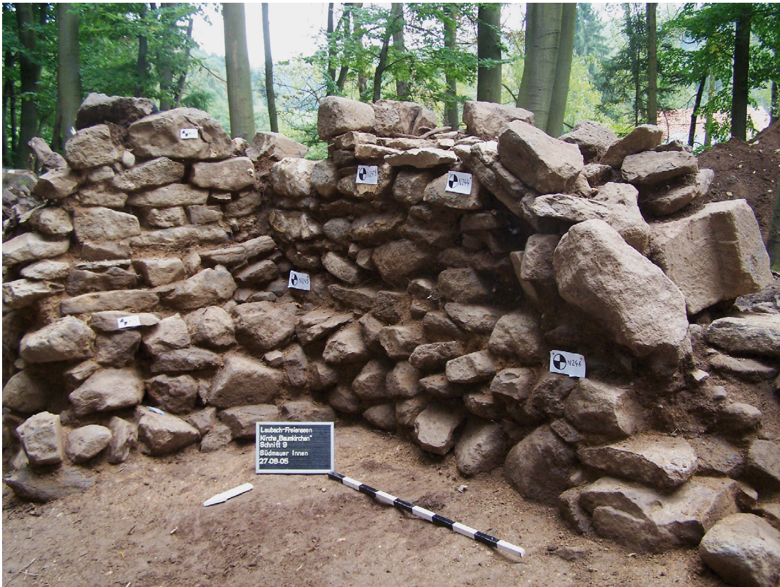
Abb. 17. Blick in die Südostecke des Kirchensaales, gebildet aus Befund 11 (links) und Befund 2 (rechts). Die vorspringende Fundamentierung ist deutlich zu erkennen (Foto: LfdH).
