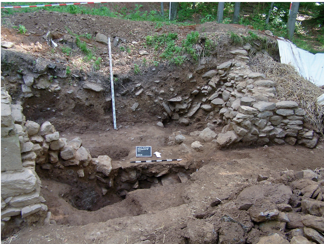
Abb. 19. Befund 229 hat im Chorbereich massive Schäden verursacht. Insbesondere Befund 46 wurde größtenteils beseitigt; rechts der Pfeiler Befund 67. Blick von Süden (Foto: LfDH).
