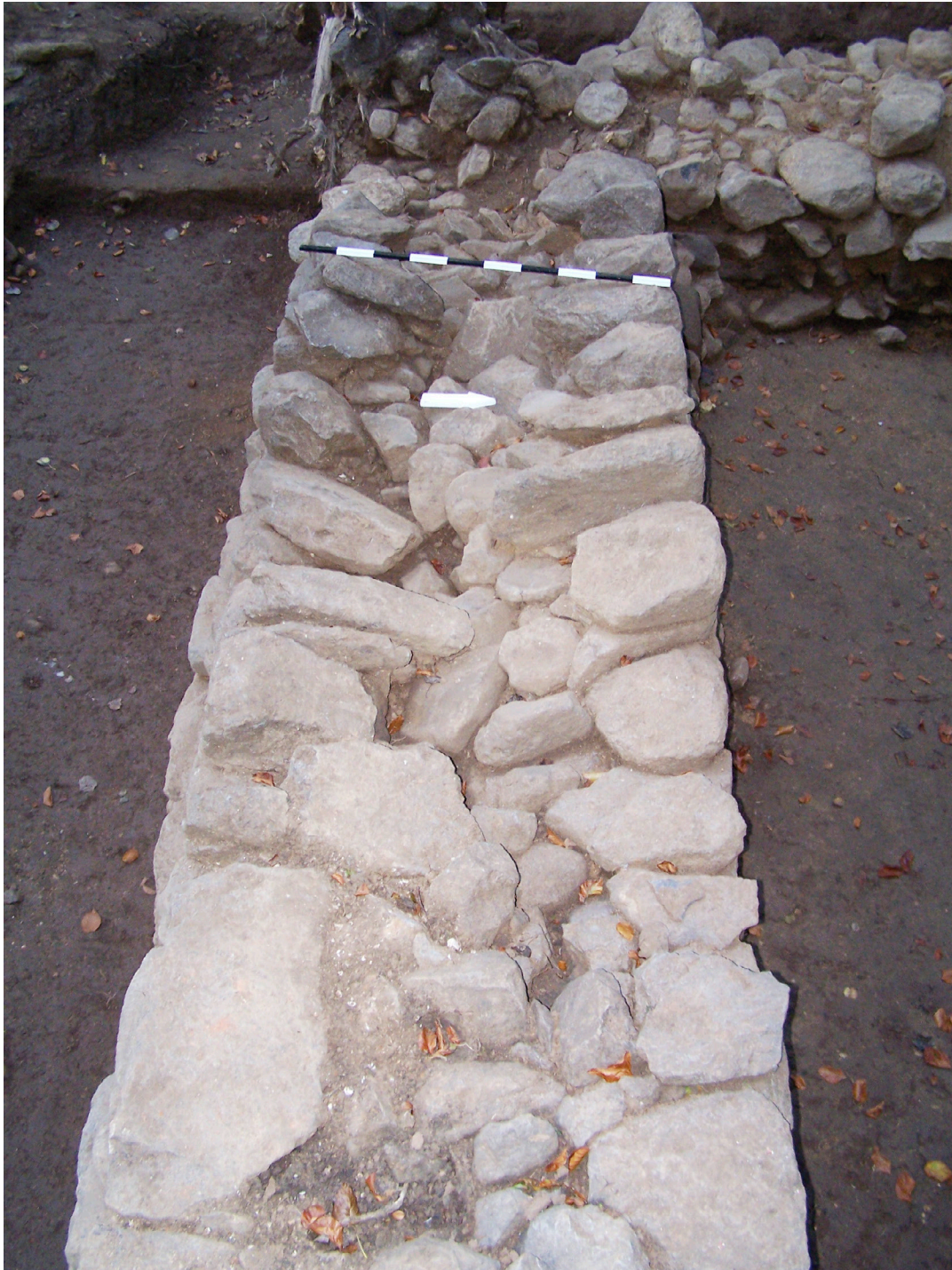
Abb. 8. Aufsicht von Befund 2 (Foto: LfDH).
