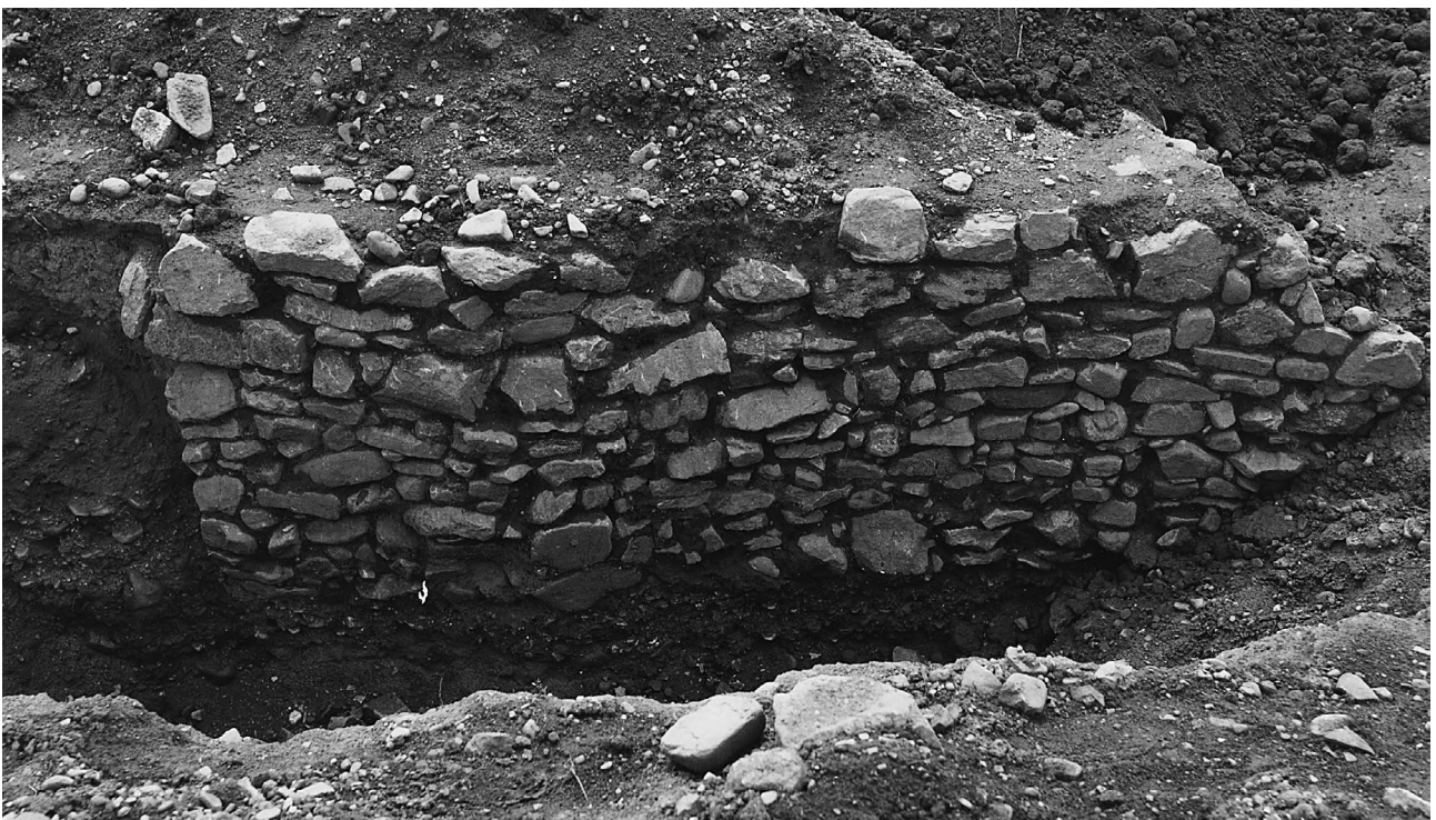
Abb. 39. Grubenhaus B/G87, Ausgrabungsbefund der Steinmauer von N (Foto: LfDH).
