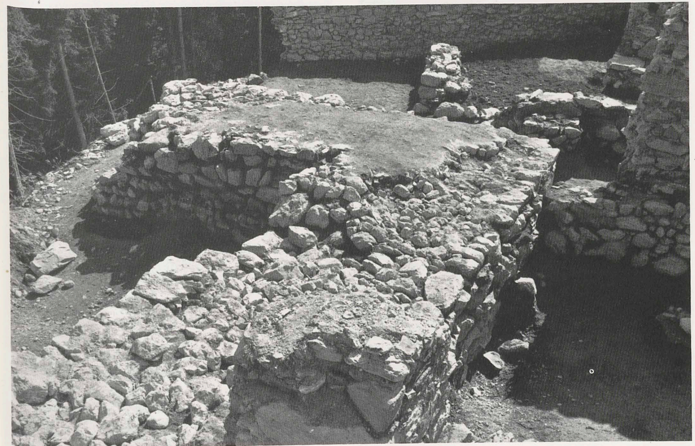
Abb. 16 Zone F, Fundament des Bergfrieds M 3. Die Mauerkrone zeigt, wie sich im unsorgfältig aufgeführten Kern Stein- und Mörtelschichten ablösen. Blick gegen Osten
