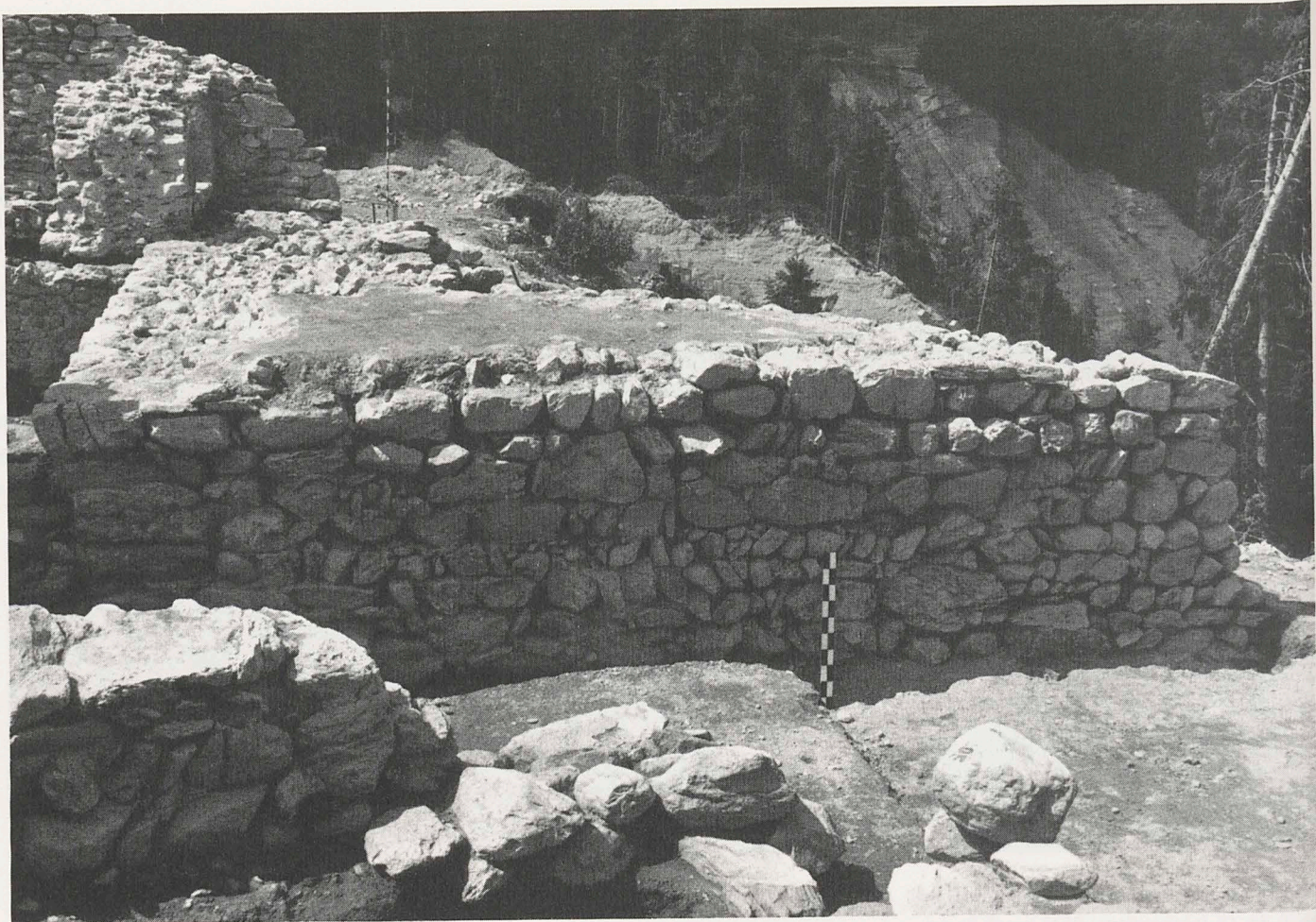
▲ Abb. 17 Zone F, Mauerwerk des Bergfrieds M 3. Das Gelniveau lag ca. 50 cm über dem aufgestellten Maßstab. Blick gegen Nordwesten
