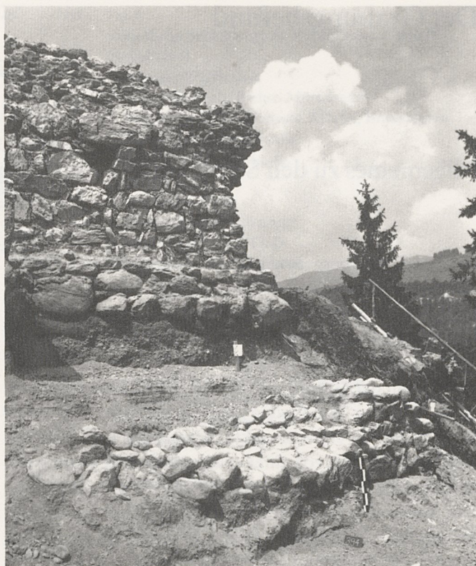
Abb. 8 Nordostbering in Zone D. Hinten die Mauern M 1 und M 44, davor Reste der älteren Mauer M 26 ▶
