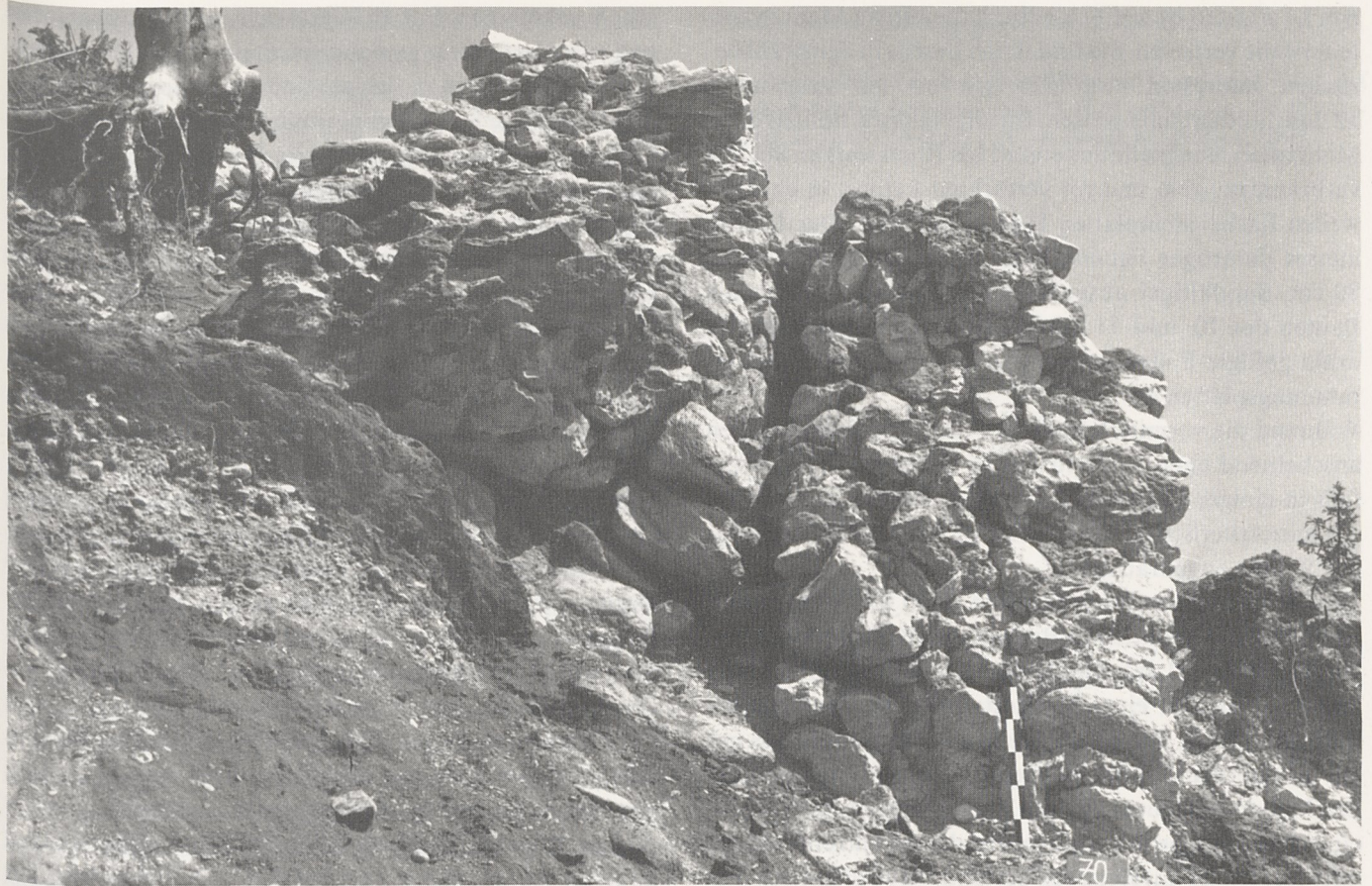
Abb. 28 Zone D, Abbruchpartie der Mauern M 1 (links) und M 44. Blick gegen Nordosten
