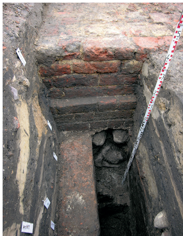
7 Stendal, Markt; Nordwand des Kaufhauses, erbaut 1178; Ziegelmauerwerk mit Steinfundament, Aufnahme von 2015 (Landesamt für Denkmalpflege und Archäologie Sachsen-Anhalt)
