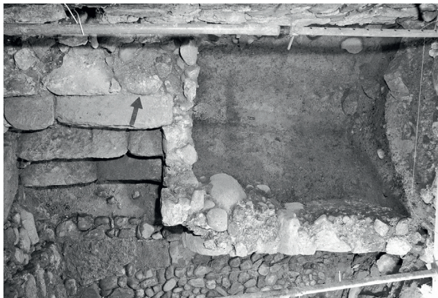
Abb. 199 Burghaus Hüenenberg, Übersicht über Raum 1. Über dem verfüllten Spitzgraben waren sekundär Treppe 313/333 und Pflasterung 332 mit seitlicher Stützmauer 335 errichtet worden.
