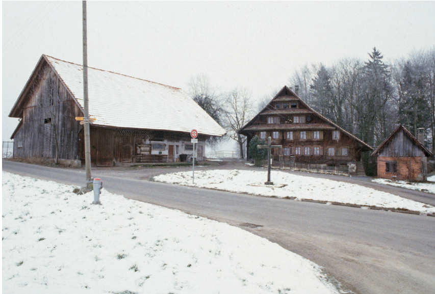
Abb. 190 Burghaus Hüenenberg (im Mittelgrund), Ansicht der Südfassade vor der Untersuchung 1994, rechts im Hintergrund der Burghügel.
