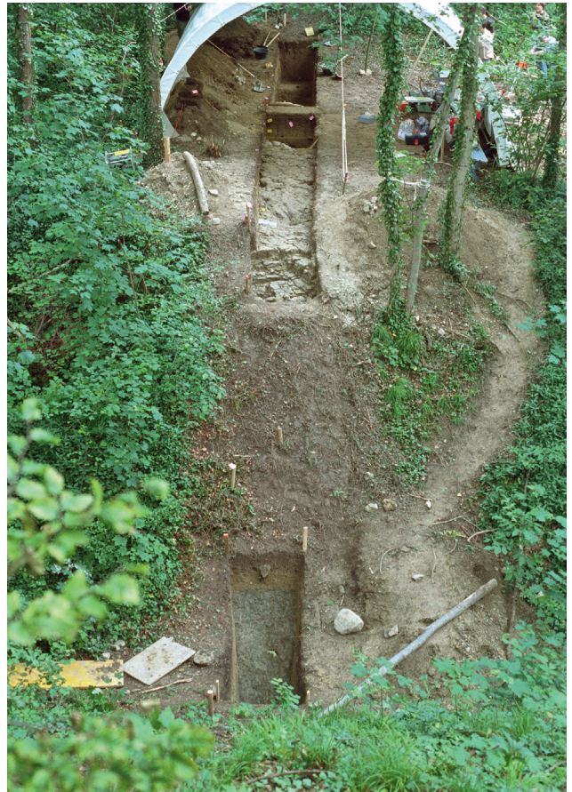
Abb. 184 Blick vom Burgplateau Richtung Norden. Der nördliche Halsgraben und das nördliche Plateau wurden in einer Nachuntersuchung 2010 mittels Sondierschnitten untersucht.
