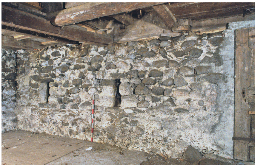
Abb. 197 Burghaus Hüenenberg, Ansicht an die Ostfassade 1/7 des Steingebäudes aus Bauphase I mit der originalen Befensterung 2, 3 und 4.
