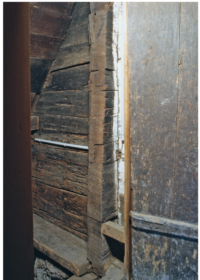
Abb. 204 Burghaus Hüenenberg, Innenansicht an die östliche Blockwand 12 und die abgesägte Binnenwand 152 im ersten Vollgeschoss.
