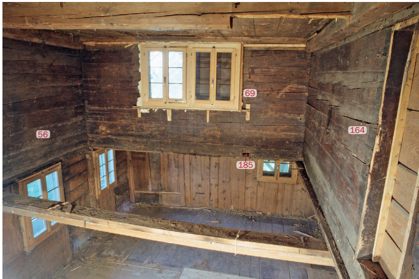
Abb. 207 Burghaus Hüenberg, Innenansicht ins erste und zweite Vollgeschoss mit Blick nach Norden.
