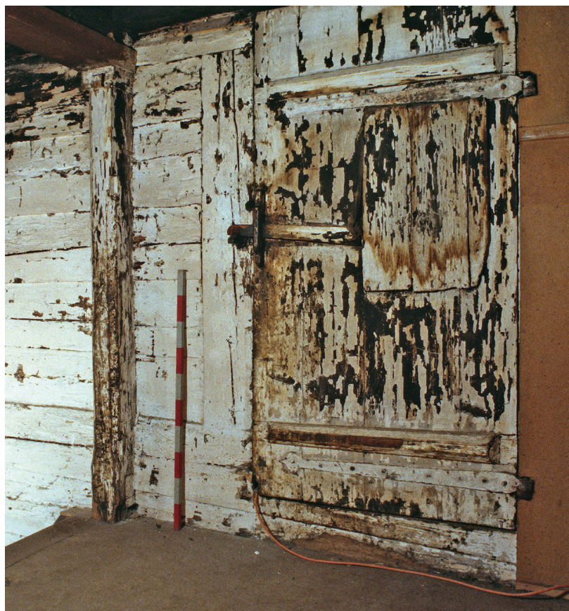
Abb. 209 Burghaus Hünenberg, Innenansicht an die ostseitige Laubentür im zweiten Vollgeschoss.
