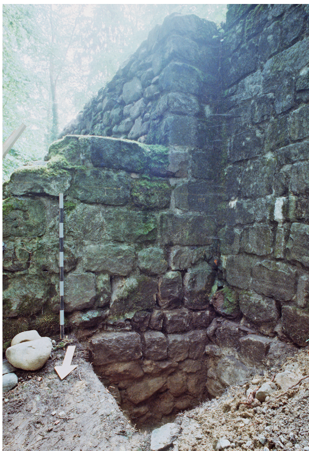
Abb. 142 Übersicht über Sondage Sg. 3 in Richtung Mauerecke der Tor-nordmauer M10 und der daran anstossenden Mauer M7 links.
