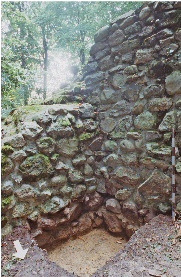
Abb. 177 Übersicht über Sondage Sg. 4 mit Blick in die Mauerecke der inneren Verstärkung M11 und M12.
