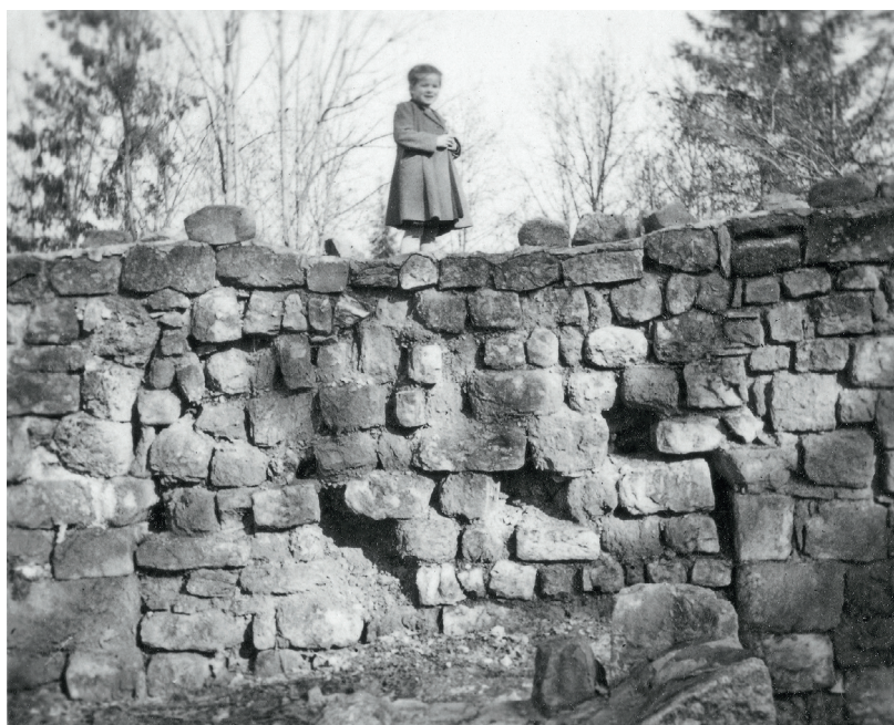
Abb. 147 Ansicht an die Westfassade des Torgebäudes M18 mit zugemauertem Torbogen M18b. Die Abbruchkrone der Mauer war nach Abschluss der Altgrabung übermauert und mit Beton abgedeckt worden.
