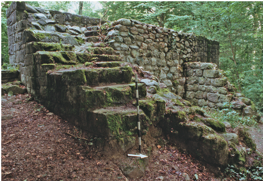
Abb. 141 Blick gegen das Torgebäude, von Südosten her gesehen. Die Torsüdmauer M20 ist treppenartig hangabwärts verstürzt und wurde 1961/1962 in dieser Form konserviert. Rechts im Bild ist die Tornordmauer M10 zu sehen, dazwischen die erst in Bauetappe IIIb eingestellten Mauern M11 und M12.
