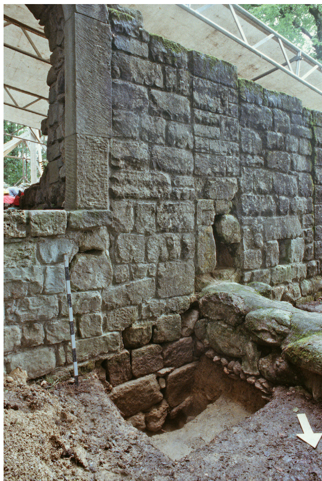
Abb. 169 Übersicht über die Sondage Sg. 12 nördlich der Palasmauer M13 mit der anstossenden Mauer M5.
