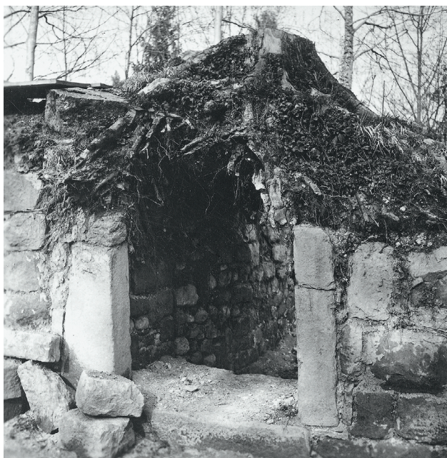
Abb. 171 Der sekundär in der Mauer M23 ausgebrochene Tüردurchgang war bei der Altgrabung vollständig von einem Wurzelstock überdeckt.
