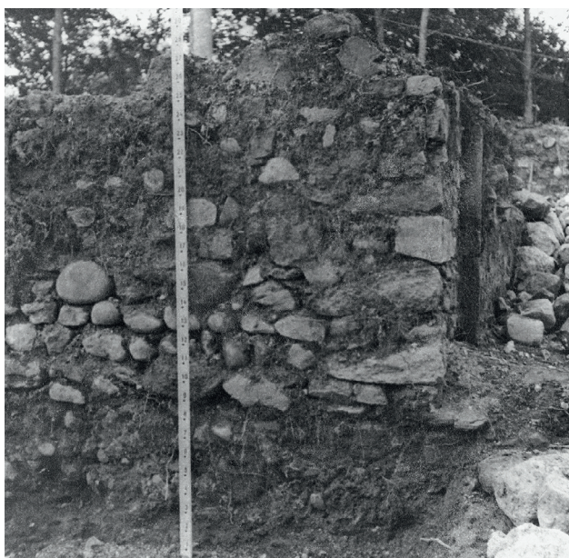
Abb. 182 Ansicht an die Westwand der Mauer M16. Der Mauerfuss war während der Altgrabung vollständig freigelegt worden. Rechts das nördliche Gewände zum Türdurchgang in den Innenhof.
