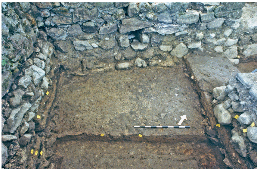
Abb. 127 Blick auf die Grabungsfläche in Feld F3 auf den untersten, fassbaren Begehungshorizont 123/137. Die jüngere Mauer M15 nimmt die Kanalöffnung 155 der Zumauerung M13a wieder auf und führt sie nach Süden fort.
