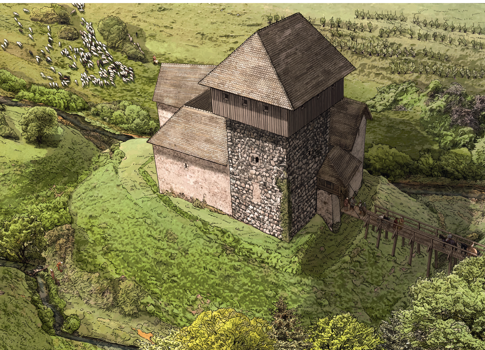
Abb. 183 Rekonstruktionsvorschlag für Bauphase IV in der zweiten Hälfte des 13. Jh. oder im 14. Jh., Blick nach Nordosten. In der letzten, fassbaren Bauphase wurde der äussere Zwinger aufgegeben und die Anlage durch die Überbauung im Innenhof stark verdichtet. Eine eigentliche Ringmauer existierte in dieser Phase nicht mehr, stattdessen bildeten die Aussenmauern der einzelnen Gebäude die Umfassung der Anlage.
