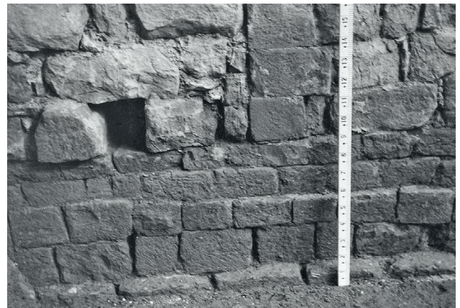
Abb. 136 Nordwand der Palasmauer M13 mit zugemauelter Türöffnung M13a und Kanal 155. Das sauber aus Quadern gefügte Mauerwerk springt mehrfach zurück, weshalb sich die Höhe des ursprünglichen Fussbodenniveaus im Rauminnern nicht sicher festmachen lässt. Die unterschiedlichen Lagehöhen des Mauerwerks sind auf die unterschiedliche Schichtmächtigkeit der natürlich anstehenden Sandsteinbänke zurückzuführen.
