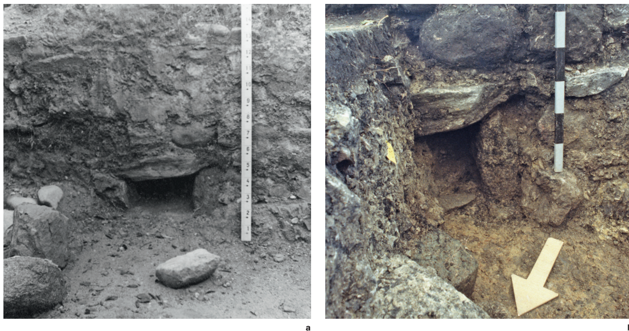
Abb. 168 Ansicht an die Nordwand der Mauer M17 mit der Kanalöffnung 155. Die Maueröffnung verlängert den Kanal 155 von der Torzumauerung M13a und M15 weiter nach Süden in Richtung Burghof. Es könnte sich dabei um eine Wasserleitung handeln, mit welcher der Sodbrunnen zusätzlich mit Dachwasser gespeist wurde. a) Zustand bei der Altgrabung; b) Zustand bei den Nachuntersuchungen 2007.
