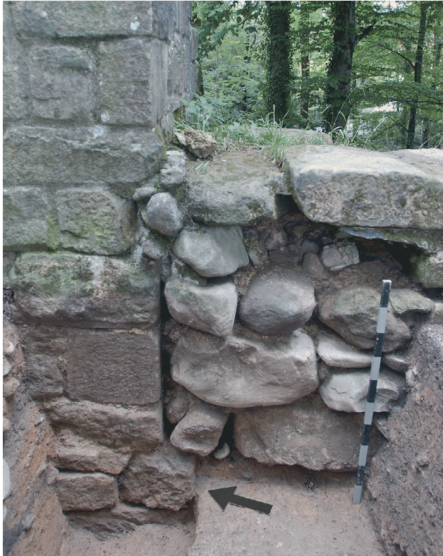
Abb. 143 Sondage Sg. 13 mit Blick nach Osten. Die jüngere Mauer M23 stösst an das Tormauerwerk M18/M20 an. Der Türdurchgang in Mauer M23 wurde erst sekundär, vermutlich erst beim Bau des Bergfrieds, eingerichtet.
