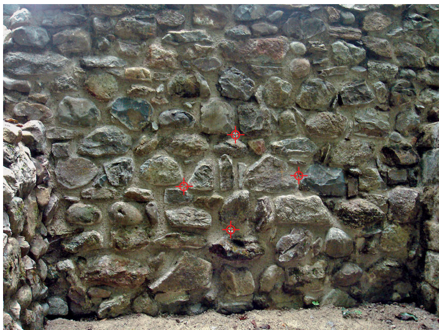
Abb. 71 Ostwand der Mauer M11 mit Ankerköpfen zum Zurückbinden der Mauerschale nach der Konservierung 2009.
