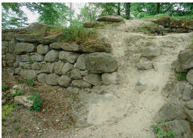
Abb. 69 Die Ruine war 2005 stark überwachsen. Auf dem Bergfried hatten kleine Bäume und Sträucher mit ihren Wurzeln Frostsprengungen und partielle Mauerausbrüche verursacht, von denen insbesondere die Südwestmauer M32 betroffen war. Aufnahme vor der Konservierung 2007–2009.
