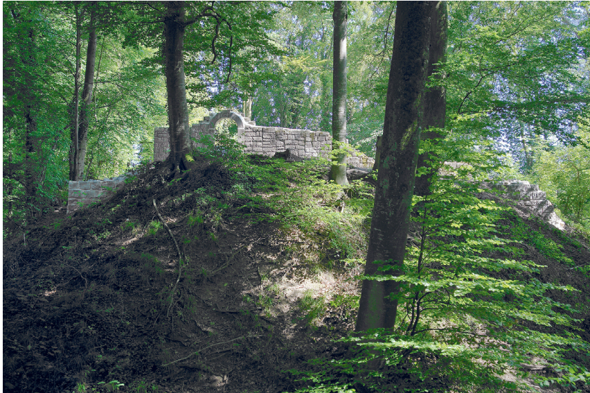
Abb. 74 Das Hauptplateau der Burg, von Norden her gesehen. Die wiederhergestellten nördlichen Mauerecken M1/M243 und M3/M4 verdeutlichen die ehemalige Grösse der Burg und die starke Hanglage der Ringmauer.
