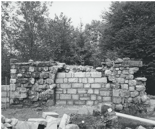
Abb. 60 Ansicht an das ehemalige Torgebäude M18. Das Foto illustriert, wie tiefgreifend die baulichen Massnahmen 1961/1962 waren. Vom aufgehenden Mauerwerk wurden umfassende Teile vollständig neu aufgeführt.
