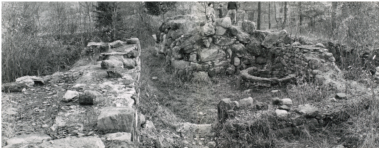
Abb. 57 Zustand der Burgruine 1959 vor der Konservierung. Die während der Altgrabung freigelegten Mauern waren durch Witterungseinflüsse stark in Mitleidenschaft gezogen worden. Blick nach Süden in Richtung Burghaus.
