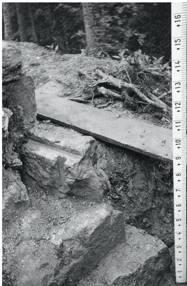
Abb. 75 Die Ecke der Palassüdmauer M13 und der westlichen Ringmauer wurde mehrfach umgebaut. Während der Altgrabung kam im Flickmauerwerk M83 eine sekundär verbaute Spolie zum Vorschein. Es handelt sich dabei wohl um einen Gewändestein mit seitlicher Einschubrinne für einen Türriegel.
