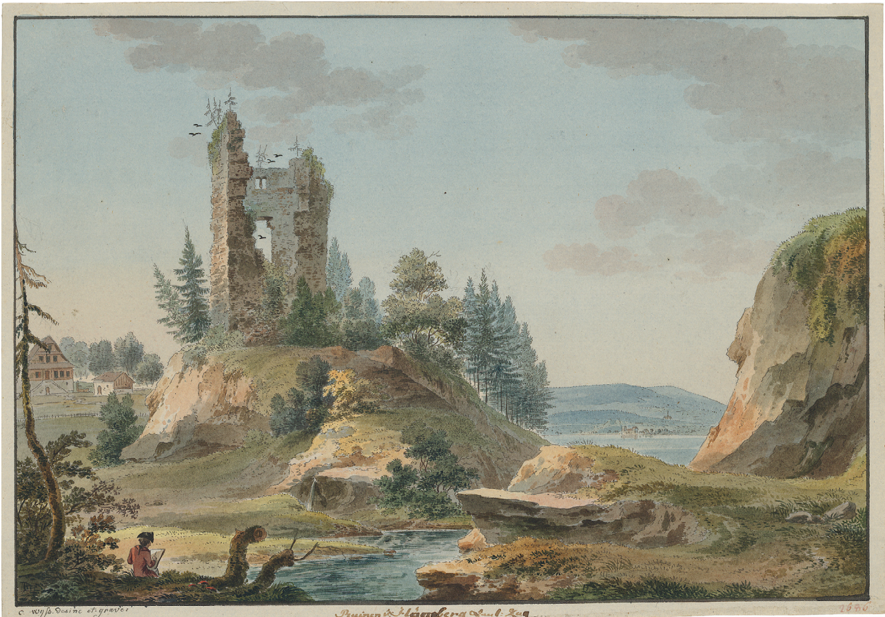
Abb. 34 Aquarellierte Federzeichnung von Caspar Wyss (1762–1798) um 1780. Die Ansicht ist etwas schwer zu orientieren, doch zeigt sie übereinstimmend mit anderen Darstellungen den tiefen Ausbruch am Bergfriedmauerwerk. Die Tür mit Schulterbogen und das gekuppelte Rundbogenfenster sind auf anderen Ansichten nicht in dieser Form überliefert.
