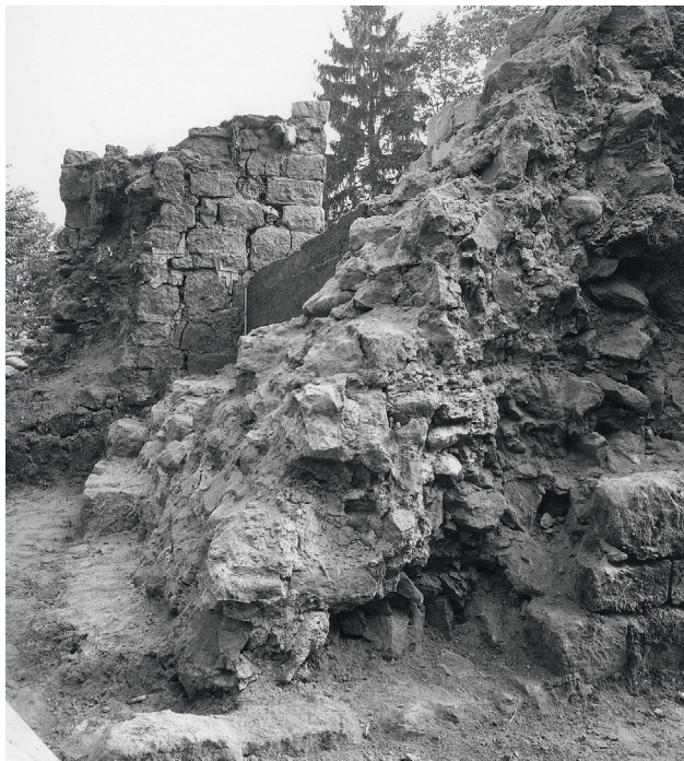
Abb. 61 Fotoaufnahme während der Restaurierung 1961/1962. Im Vordergrund ist die stark zerfallene Mauer M6 zu sehen, im Hintergrund zeigte sich nach Abbruch der Mauer M7 die Nordfassade M10 des ehemaligen Torgebäudes mit anhaftenden Verputzresten.
