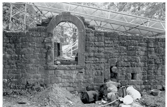
Abb. 59 Mauer M6/M13 mit Maueröffnung. Die Fotografien zeigen den dramatischen Zerfall des nach der Ausgrabung freigelegten Mauerwerks. a) Zustand nach der Freilegung 1946, im Vordergrund ist zudem die Pforte in der nördlichen Ringmauer M1/M3 erkennbar; b) Zustand nach Abschluss der Altgrabung mit rekonstruiertem Torbogen; c) Bestandaufnahme vor der Konservierung 1961/1962; d) Arbeitsaufnahme 2007.
