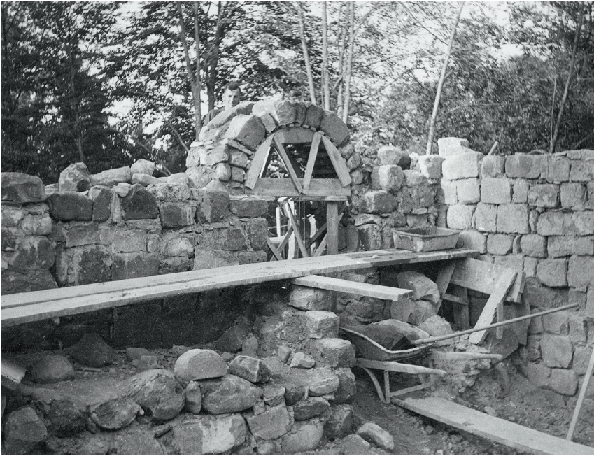
Abb. 47 Nach Abschluss der Ausgrabung wurden Teile der Burg mit originalen Bausteinen rekonstruierend wiederaufgebaut; dies zum Teil nicht in Übereinstimmung mit den archäologischen Befunden.
