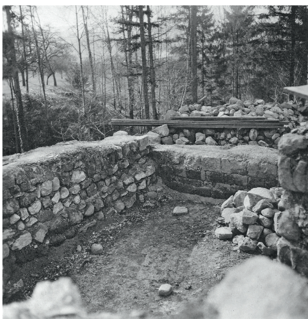
Abb. 53 Die Mauern M13 und M14 bilden heute eine geschlossene Mauererecke. Nach Ausweis dieses Fotos wurden die Mauern aber offensichtlich zu unterschiedlichen Zeiten und nicht im Verband miteinander errichtet.
