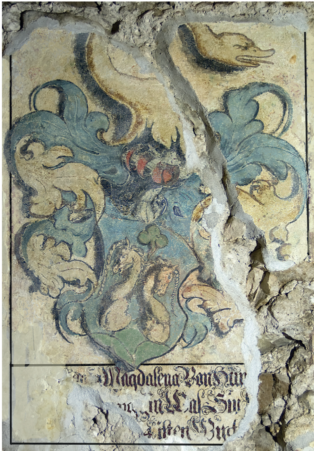
Abb. 27 Im Jahr 2017 kam bei Bauuntersuchungen an der Kirchenstrasse 3 in Zug eine gut erhaltene Wappenmalerei zum Vorschein. Sie muss um 1631 auf Initiative von Oswald II. Zurlauben († 1637) entstanden sein und zeigt das Wappen von Oswalds erster Frau Magdalena Bengg von Hüenenberg († 1629). Das Hüenenberger Wappen mit den zwei Einhornköpfen und dem Schwanenhals ist um die Bengg'schen Kleeblätter ergänzt.
