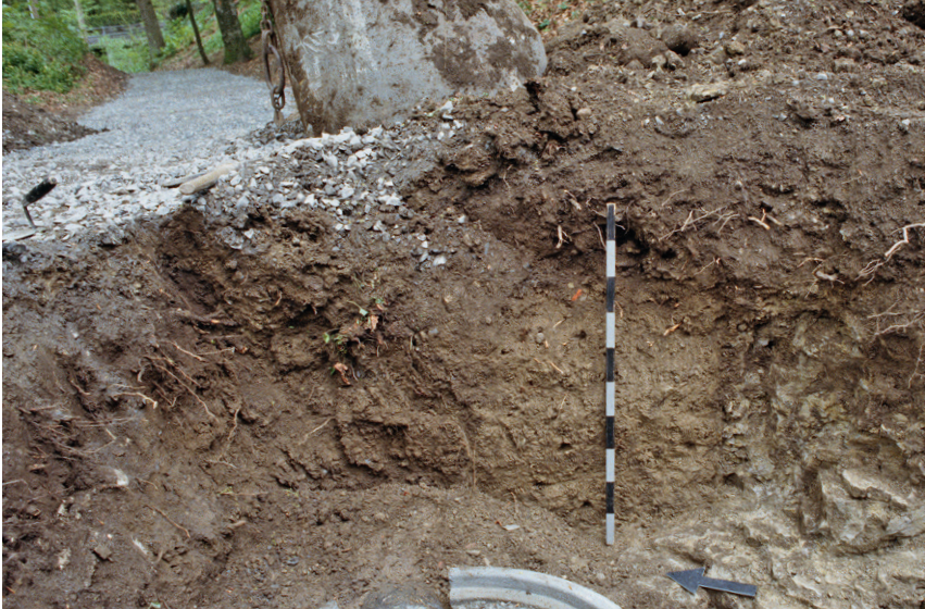
Abb. 11 Ein 2002 geöffneter Leitungsschacht lieferte bislang die einzige Möglichkeit, den Verlauf des Felses im südlichen Halsgraben zu dokumentieren. Der rechtwinklige Absatz rechts vom Meterstab spricht klar für menschliche Eingriffe. Diese können jedoch bei der Schaffung des Zugangswegs durch überlieferte Felssprennungen während der Altgrabung oder gar erst beim Anlegen des genannten Leitungsrabens entstanden sein.
