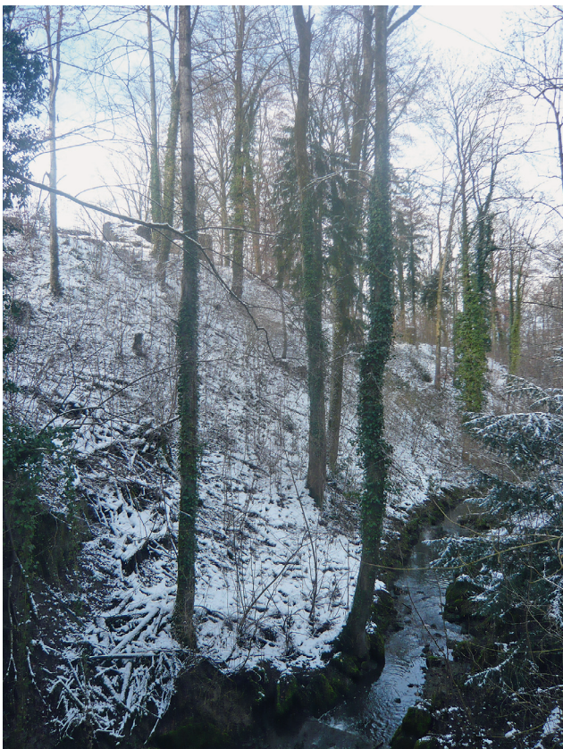
Abb. 5 Der Geländesporn fällt auf seiner Ostseite relativ steil zum Dorfbach hin ab. Hier haben sich in der Anfangszeit der Burg statische Probleme bemerkbar gemacht, da die ältesten Mauern nicht bis auf den Fels fundiert gewesen waren.
