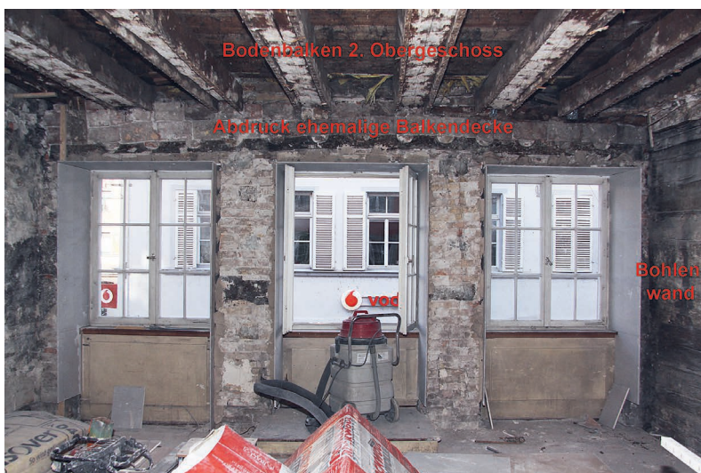
9 Bohlenstube im Haus „Zum Bub“. Oberhalb der später veränderten Fenster zur Straße ist das Auflager für die ehemalige Bohlen-Balken-Decke erkennbar, rechts die zugehörige Bohlenwand (Hussenstr. 1, Osthälfte/Bauteil C; Aufnahme vor Brand 2010).
