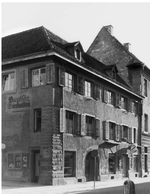
9 Das Haus „Zum Weingarten“ in der Hussenstrasse, das zusammen mit dem danebenliegenden „Weißen Pfau“ 1961 abgebrochen wurde.
