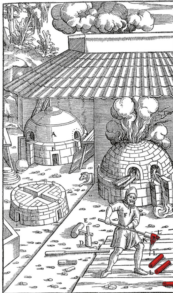
Das Ofengewölbe A. Sein Sockel B. Die Kanäle C. Der Klöppel D. Der Schlägel E. Der Treiber macht nach römischer Art Röhren aus Glätte F. Die Glättgasse G. Die Glätte H. Der tiefer gelegene Herd I. Der Glättspieß K. Die Glätteröhren L.
