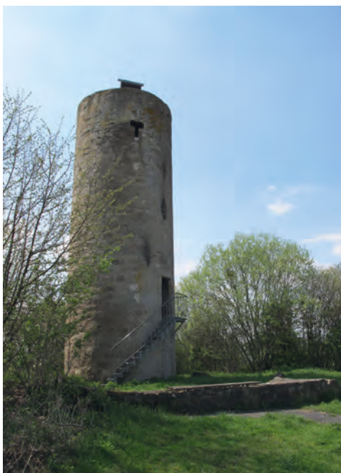
Abb. 239 Wartturm bei der Ortswüstung Latervelde. Diese Türme haben charakteristischerweise auf der stadtzugewandten Seite einen hochliegenden Eingang besessen (Foto: K. Bergmann, Paderborn).
