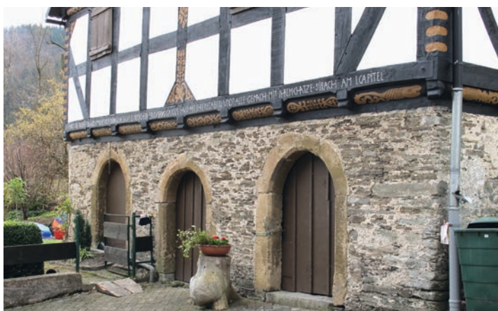
Abb. 213 Der große Speicher des Fresenhofes ist nach der Bauinschrift im Jahr 1708 errichtet worden und gehört wahrscheinlich der zweiten Gebäudegeneration nach dem Wiederentstehen des Ortes an (Foto: LWL-Archäologie für Westfalen/F. Klatt).
