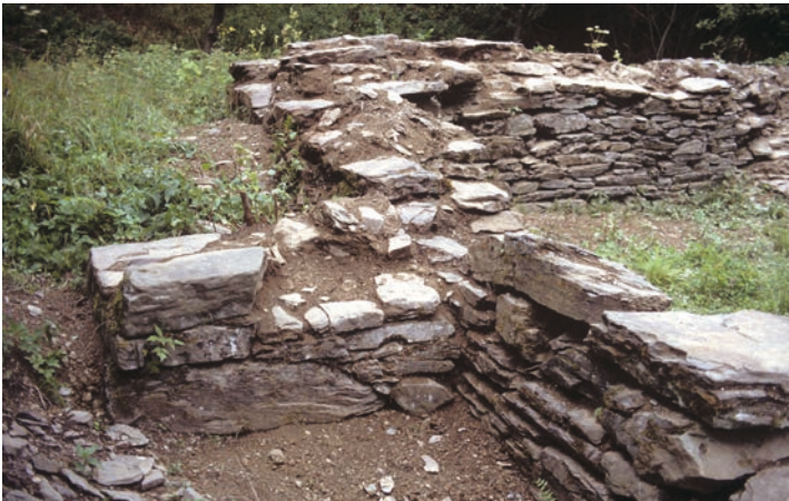
Abb. 157 Freigelegte Pfeilerfundamentierung, die nachträglich mittig außen an die Westseite des Kirchenschiffs der Wernsdorfer Kapelle angefügt worden ist (Foto: LWL-Archäologie für Westfalen/R. Bergmann).
