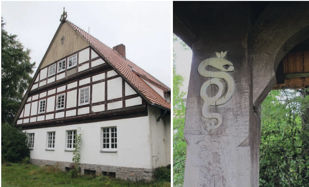
Abb. 104 Das Haupthaus des ehemaligen Gutes Wieringsen (links) ist in einem pseudorenaissancezeitlichen Baustil des Nationalsozialismus errichtet worden. Das mit Schnitzwerk verzierte, verfallende Torhaus (rechts) zeigt Anklänge an ein vermeintliches »germanisches Ahnenerbe« (Fotos: LWL-Archäologie für Westfalen/R. Bergmann).
