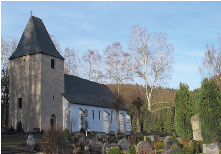
Abb. 99 Die Kluskapelle ist die ehemalige Pfarrkirche der Ortswüstung Upsprunge (Foto: K. Bergmann, Paderborn).
