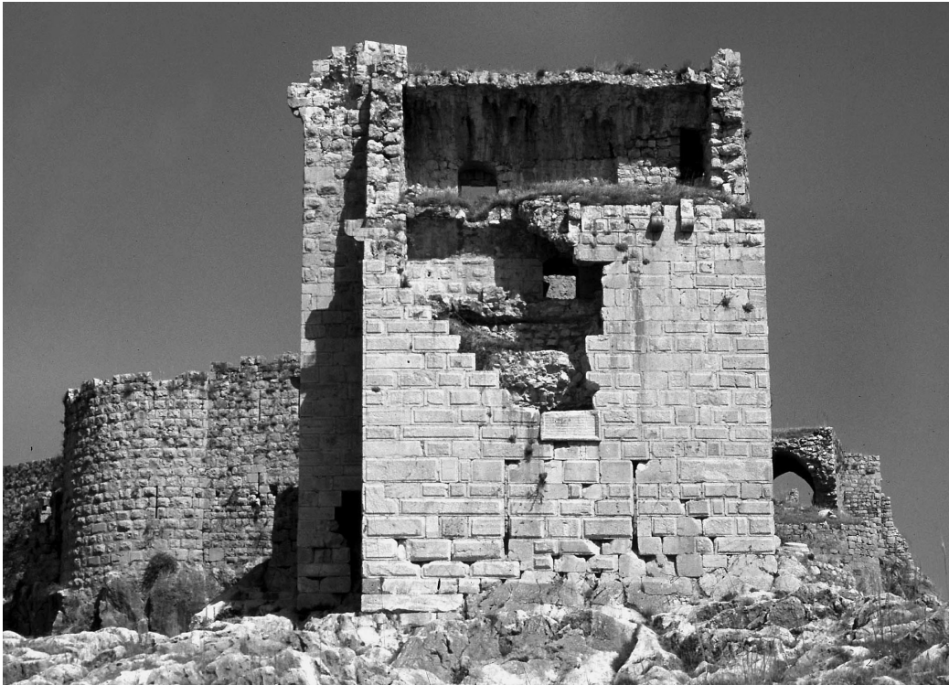
Abb. 4 Burg Anavarza, Kilikien, Türkei. Donjon und südliche Ringmauer der Oberburg (Foto: Stanzl).
