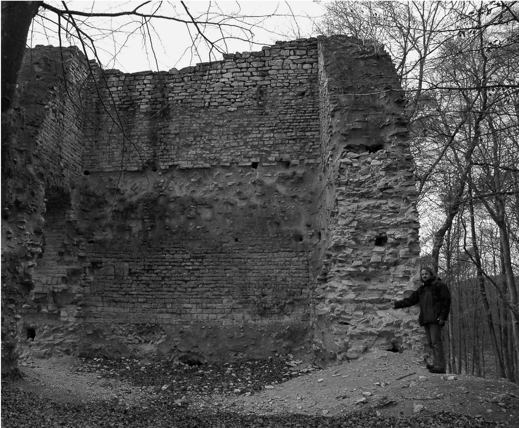
Abb. 7 Aach (KN), Alter Turm, Erosion an der frisch restaurierten Burgmauer, 2008 (Foto: RP Freiburg, Ref. 26).
