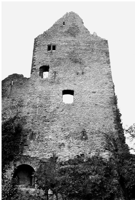
Abb. 4 Burgruine Landeck, Obere Burg, Ostwand des Palas im Zustand nach der Mauerwerkssanierung (Foto Stefan King).
