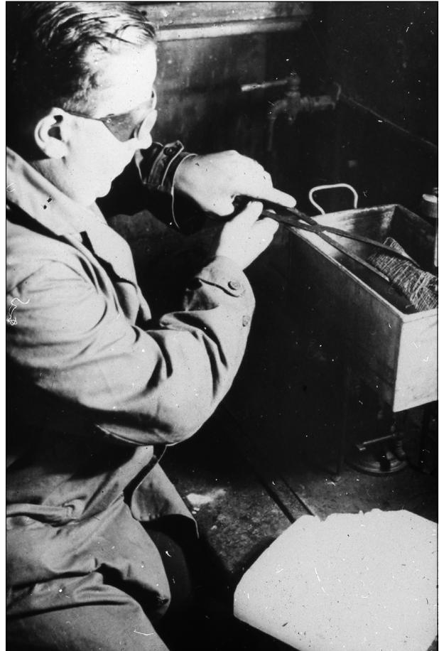
**Abb. 53** Tränkung erhitzter und mit Draht bandagierter Eisenfunden im erwärmten Paraffin am Berliner Chemischen Laboratorium in den 1930er Jahren.
