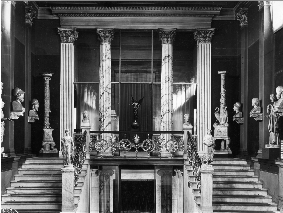
Abb. 11 Brückenübergang in das Alte Museum mit Blick in das Vestibül des Antiquariums.
