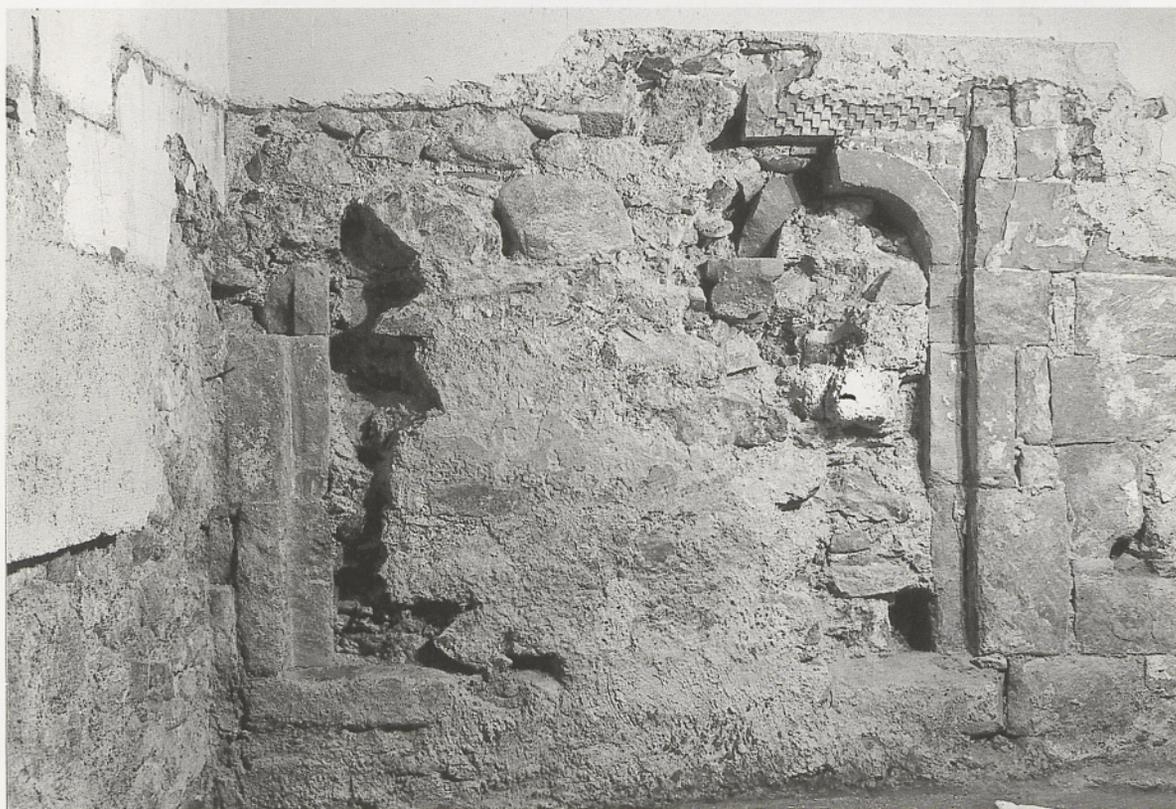
Abb. 24 Das mit der Aufgabe des Kapitelsaales in gotischer Zeit zugemauerte nördliche Kapitelsaalfenster. Die rechte Arkade und der mit einem Würfelfries verzierte Sturz sind noch erkennbar.
