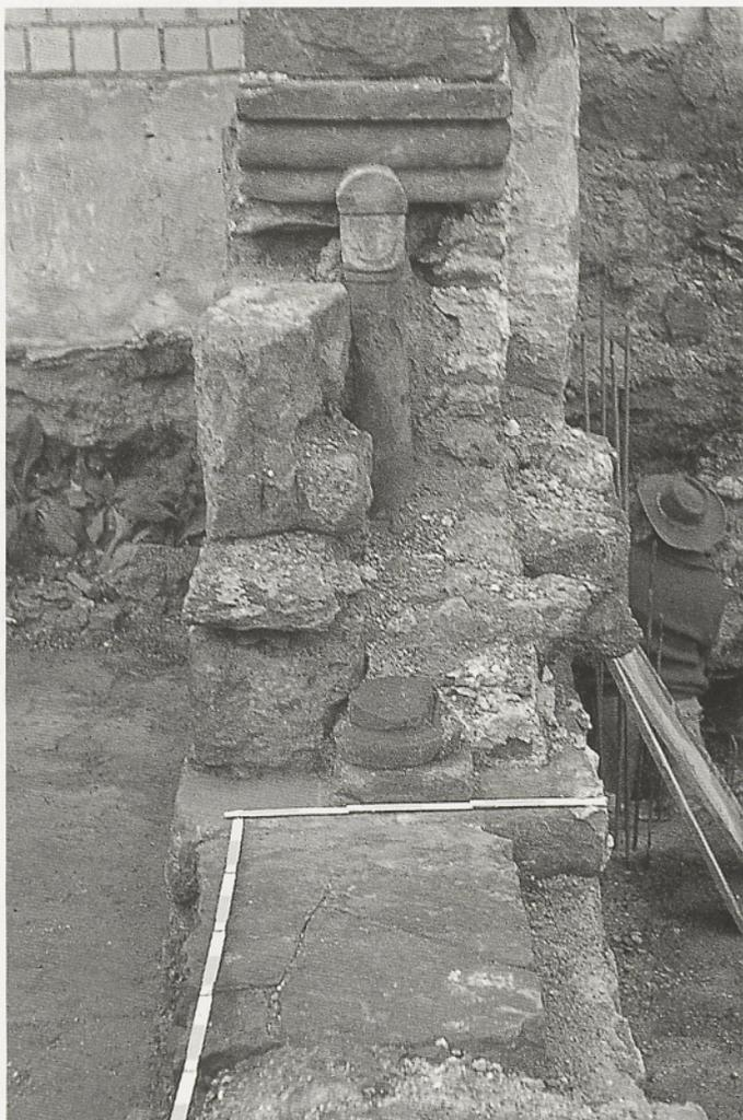
Abb. 26 Die Reste des beim Abbruch der Archivmauern 1973 stark beschädigten südlichen Kapitelsaalfensters zeigen, daß die drei Arkaden von kleinen Säulchen mit Würfelkapitellen und ungewöhnlichen Rundstabskämpfen getragen werden.
