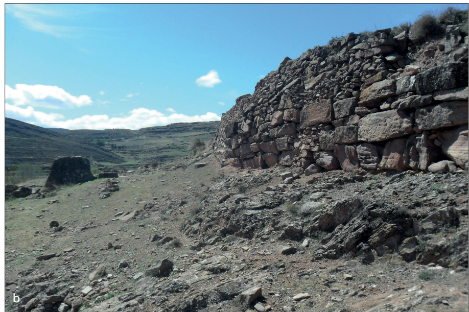
Fig. 203 Lienzo de aparejo ciclópeo, junto a la puerta principal del oppidum de El Castejón (a-b). – (Fotografías A. Lorrio / J. I. Royo).
