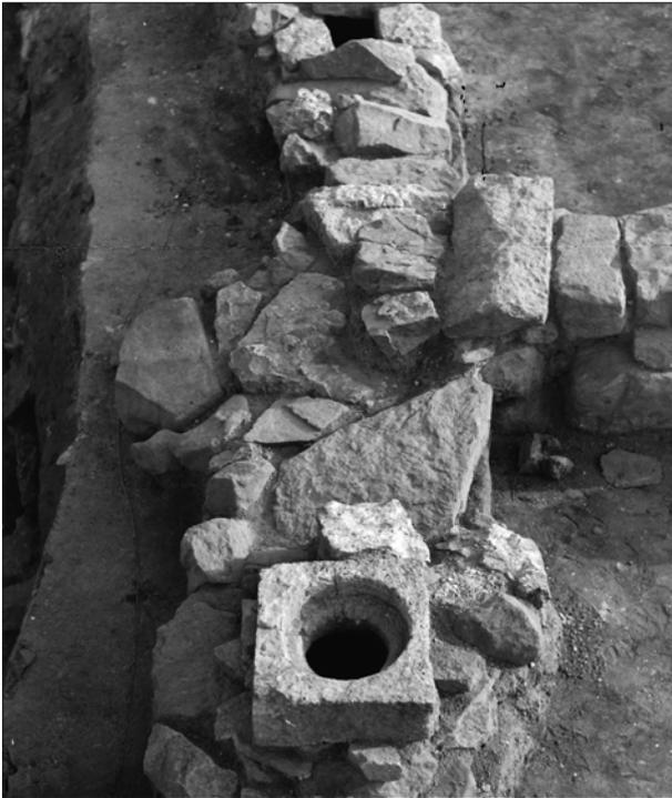
**Abb. 104** Werla, Gebäude G 3: Blick von Norden auf den westlichen Heizkanal mit Auslassstein für Warmluft, rechts der Ansatz des Fuchskanals (1939). – (Foto Archiv BLM).
