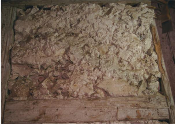
**Abb. 98** Schloss Herzberg, Uhrenturm: Innenwand des Treppenhauses, Ausführung der Gefache in Kletterschaltechnik (2017). – (Foto M. C. Bleich, NLD Hannover).
