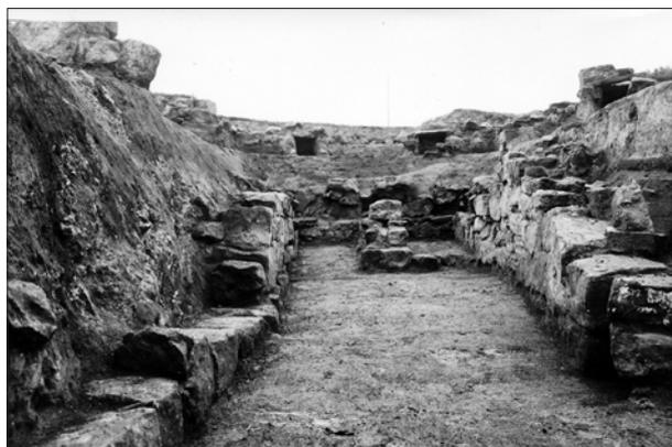
**Abb. 110** Werla, Gebäude G 3: Die Heizkammer während der Ausgrabung, mit dem Vorraum (vorn) und der zweigeteilten Brennkammer (hinten). Im oberen Teil des Profils zwei der Heißluftgänge (August 1939). – (Foto Archiv BLM).
