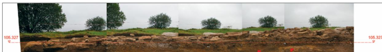
**Abb. 51** Werla, Kapelle: Südwand des Langhauses Befund 28, Montage der entzerrten Messbilder mit nachtragener Bezugshöhe üNN. Ansicht von Norden (Innenraum). – (Fotomontage S. Harnack, NLD Braunschweig). – M. 1:150.
