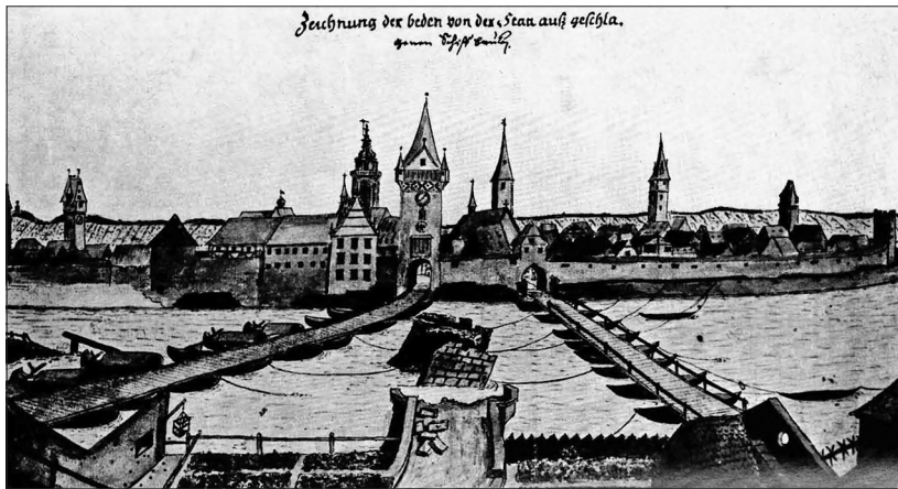
Abb. 169 Darstellung der zerstörten Brücke von Heilbronn und der beiden als Ersatz dienenden Schiffsbrücken. – (Scheffold 1955, Abb. 2666).
