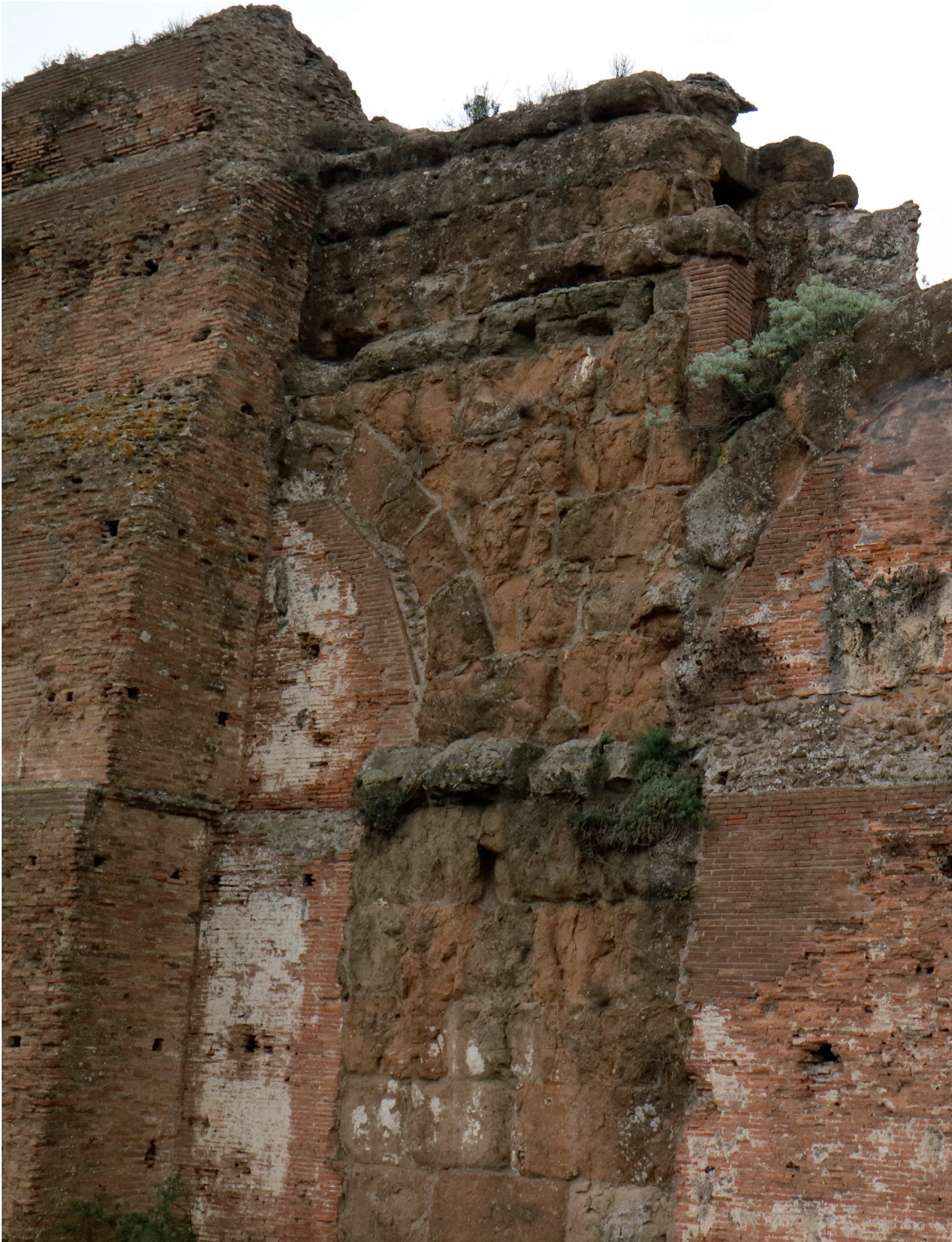
Fig. 3: Differenti tipi di tufo impiegati nel tratto di Porta Furba, e cortina laterizia in facciavista sul lato della muratura di ispessimento tarda.
