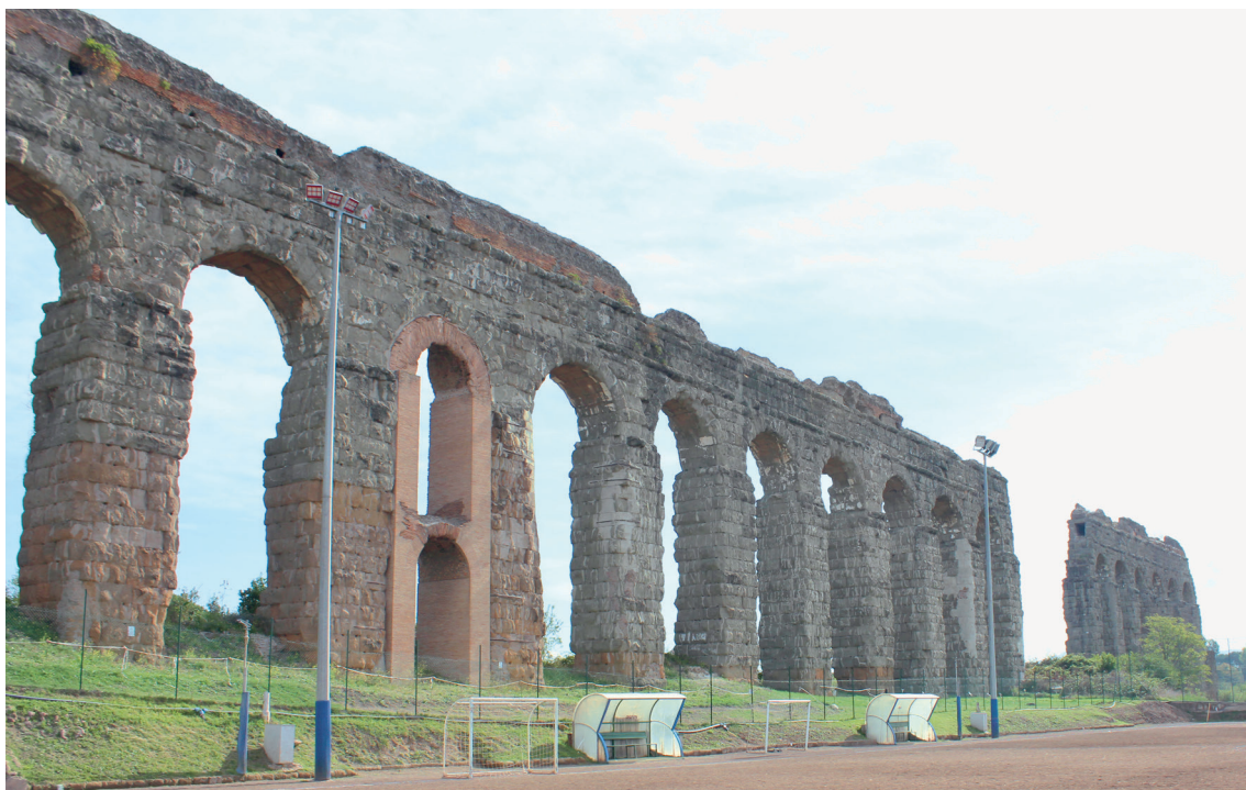
Fig. 1: Esempio di piloni composti da materiale misto, nel tratto presso Via del Quadraro.
