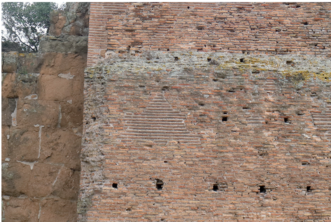
Fig. 8: Restauro moderno che oblitera la specchiatura in opera reticolata rilevata da Ashby.
