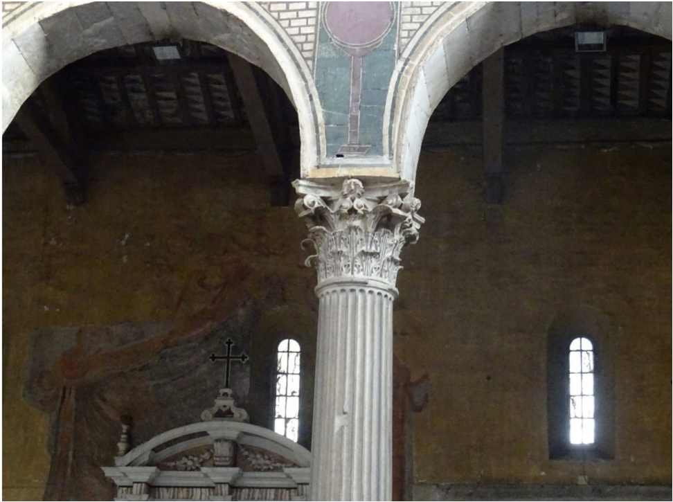
Abb. 5: Santa Sabina, Blick in das südliche Seitenschiff. Die kannelierten Säulenschäfte mit den korinthischen Kapitellen sind Werkstücke des 2. Jh. n. Chr. und bilden in der gesamten Kirche einen einheitlichen Satz.
