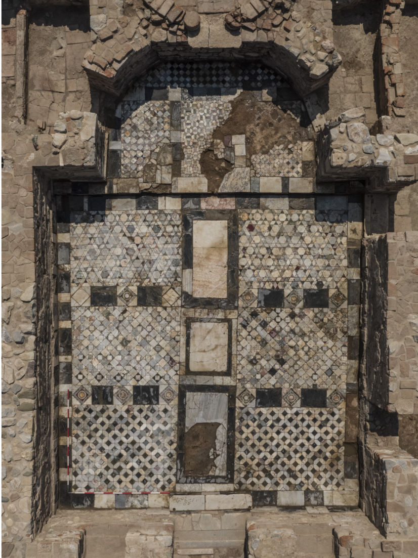
Abb. 2: Apsidensaal (R. 1. 16) in Wohneinheit 1 vom spätantik-mittelalterlichen Stadtquartier südlich der Marienkirche.
