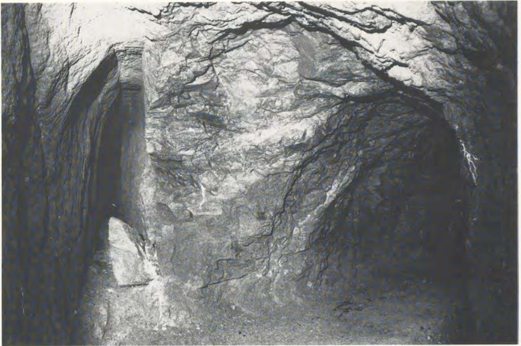
Abb. 10 Kreuzung in der Grube Engelsburg bei Sainte-Marie-aux-Mines; links: Schrägstollen aus dem 16. Jahrhundert, rechts: moderne Strecke von 1898 (Photo P. Fluck).
