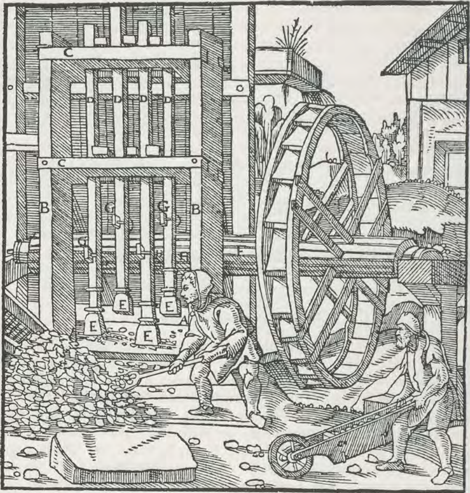
Abb. 18 Trockenpochwerk. Nach G. Agricola, De Re Metallica Libri XII (1556) Abb. VIII/143: Der Pochtrog A. Die Pochsäulen B. Die Querhölzer C. Die Stempel D. Die Pochschuhe E. Die Welle F. Der Hebling G. Der Däumling H.
