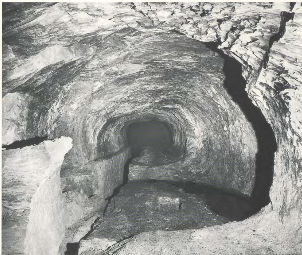
Abb. 16 Três Minas. Galeria do Pilar. Kammer eines göpelartig betriebenen Hebewerks von Nordnordwesten. Im Zentrum Aussparung für das Lager der senkrecht gestellten Welle.
