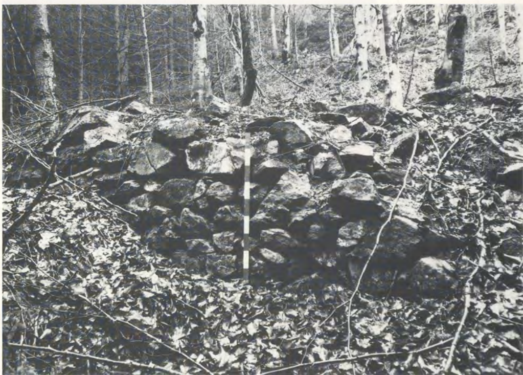
Abb. 4 Todtnauberg bei Todtnau: Trockenmauerwerk zur Stützung einer Terrasse in unmittelbarer Nähe eines Stollenmundloches; Befund mit Arbeitsflächen und Bergschmiede (13./14. Jh.).
