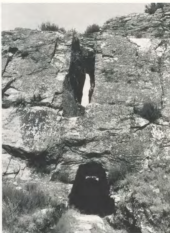
Abb. 10 Três Minas. Corta da Ribeirinha (Tagebau B). Nördliche Böschung mit Resten älterer Grubenbaue. Unten: manns- hoher Stollen mit trapezförmigem Quer- schnitt.
