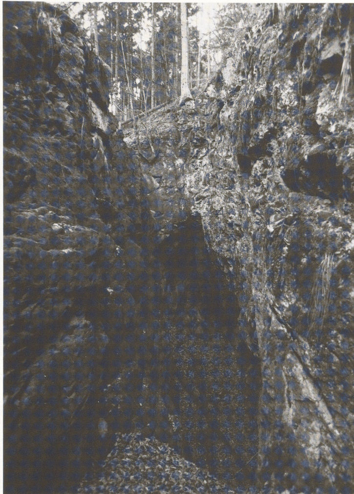
Abb. 2 Kropbach, Gem. Münstertal: Tagebau (sog. Verhau) auf einem Blei-Silber- erzgang.
