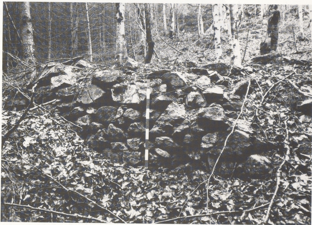
Abb. 4 Todtnauberg bei Todtnau: Trockenmauerwerk zur Stützung einer Terrasse in unmittelbarer Nähe eines Stollenmundloches; Befund mit Arbeitsflächen und Bergschmiede (13./14. Jh.).
