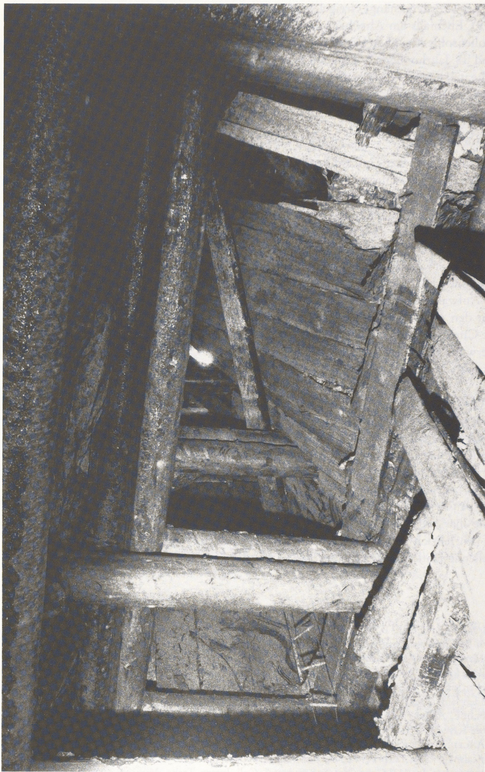
Abb. 9a Verzimmerung (um 1673) eines Schachtes bei Fortelbach, Sainte-Marie-aux-Mines (von unten nach oben gesehen). Einige Bretter sind verkippt (Photo P. Fluck).
