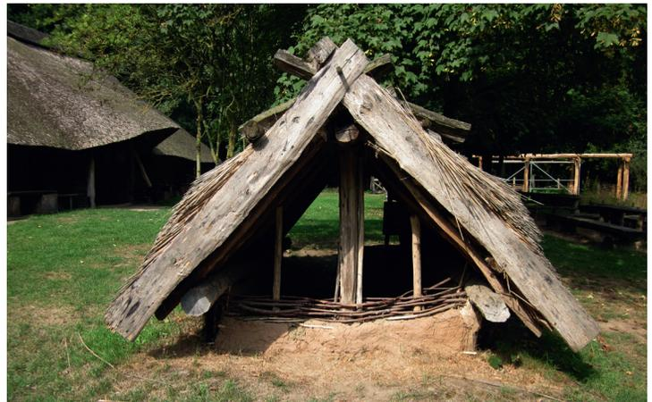
Abb. 7 Rekonstruktion eines frühmittelalterlichen Grubenhauses, »Sachsenhof«, Greven-Pentrup (Foto: K. Nowak-Klimscha).
