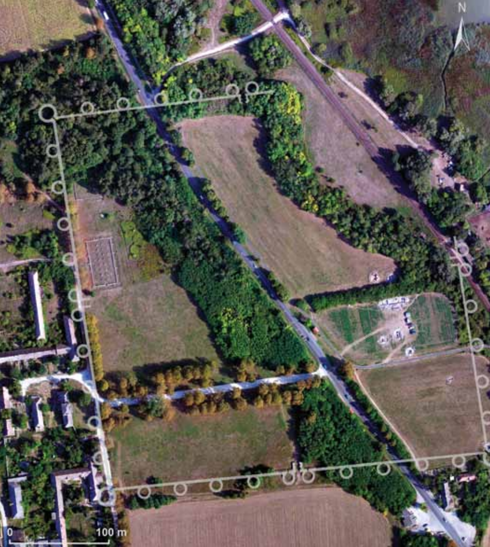
Abb. 8 Keszthely-Fenekpuszta. Luftbild des Areals während der Ausgrabungen im Sommer 2017 mit den eingezeichneten Mauern und Türme des Castrum. – Drohnenaufnahme: KC.
