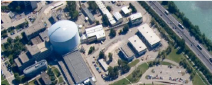
Abb. 5. Das Reaktorgebäude des ILL. Rechts in 100 m Abstand das 13 m hohe Detektorgebäude zur Suche nach Neutron-Antineutron Oszillationen, dahinter die Autobahn nach Lyon und der Fluss Drac.
