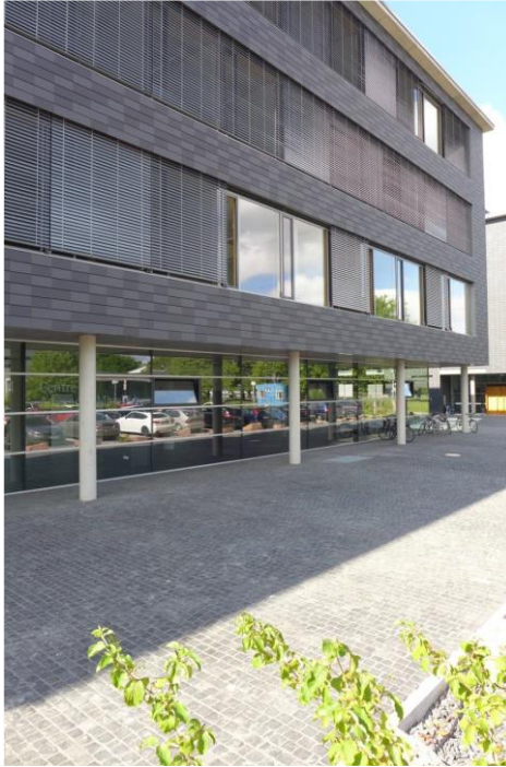
Abb. 10. Nordseite des CAM-Gebäudes.
