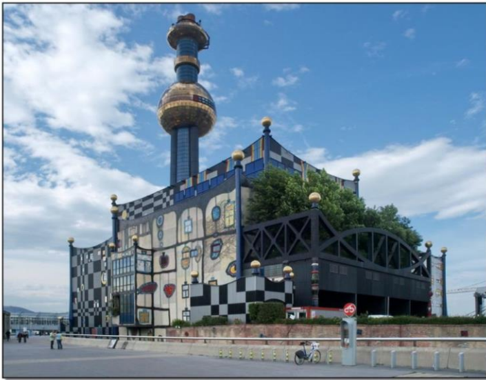
Abb. 21. Müllverbrennungsanlage der Stadt Wien.
