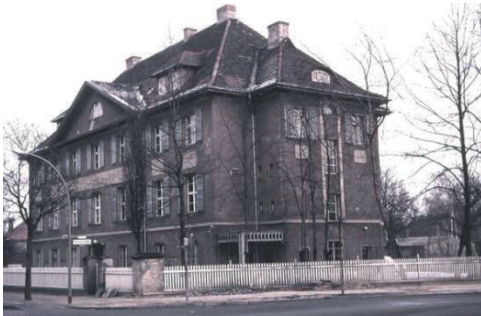
Abbildung 1. Gebäude des Astronomischen-Rechen-Instituts in Berlin-Dahlem, erbaut 1911/12. Aufnahme 1966.
