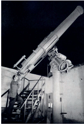
Abbildung 2. R.W. am Bamberg-Refraktor (12 Zoll / 31 cm Objektiv-Öffnung, 5 Meter Brennweite) der Wilhelm-Foerster-Sternwarte, damals noch in der Papestraße. Aufnahme um 1956/57
