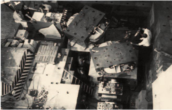
Abb. 5. Der 10 Meter kurze Kaonstrahl, aufgebaut auf einer 30 Grad schiefen Ebene.
