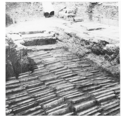
Unterirdisches Depot mit eingelagerten Steinplatten während der Ausgrabung
